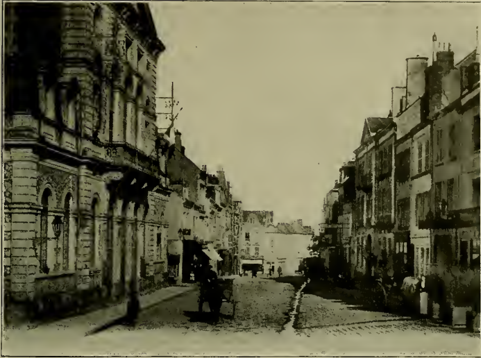
NOGENT-LE-ROTROU—RUE DE LA CHARRONNERIE.
