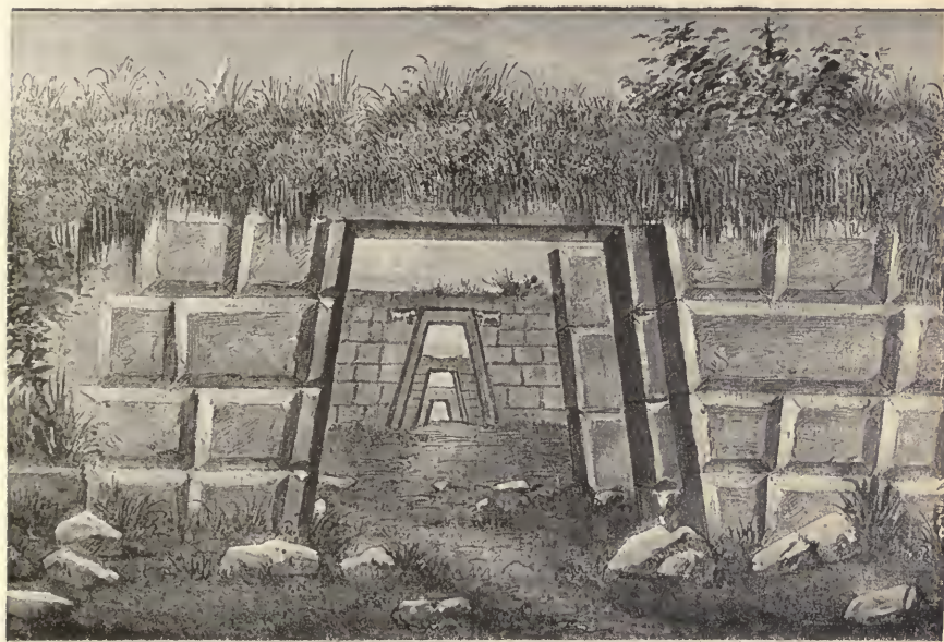
Abertura de puerta hallada en las ruinas del templo de Huanuco Viejo.
