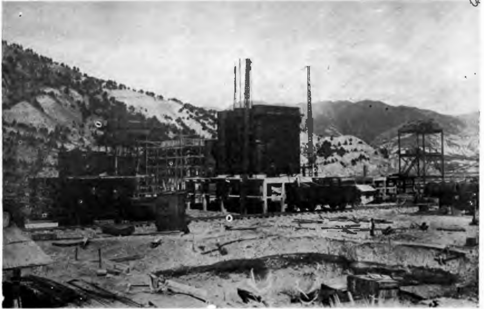
S. B. Karabük demir ve çelik fabrikası inşaatı faaliyetinden
