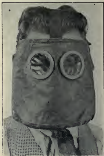
FIG. 46.—French M-2 Mask.
