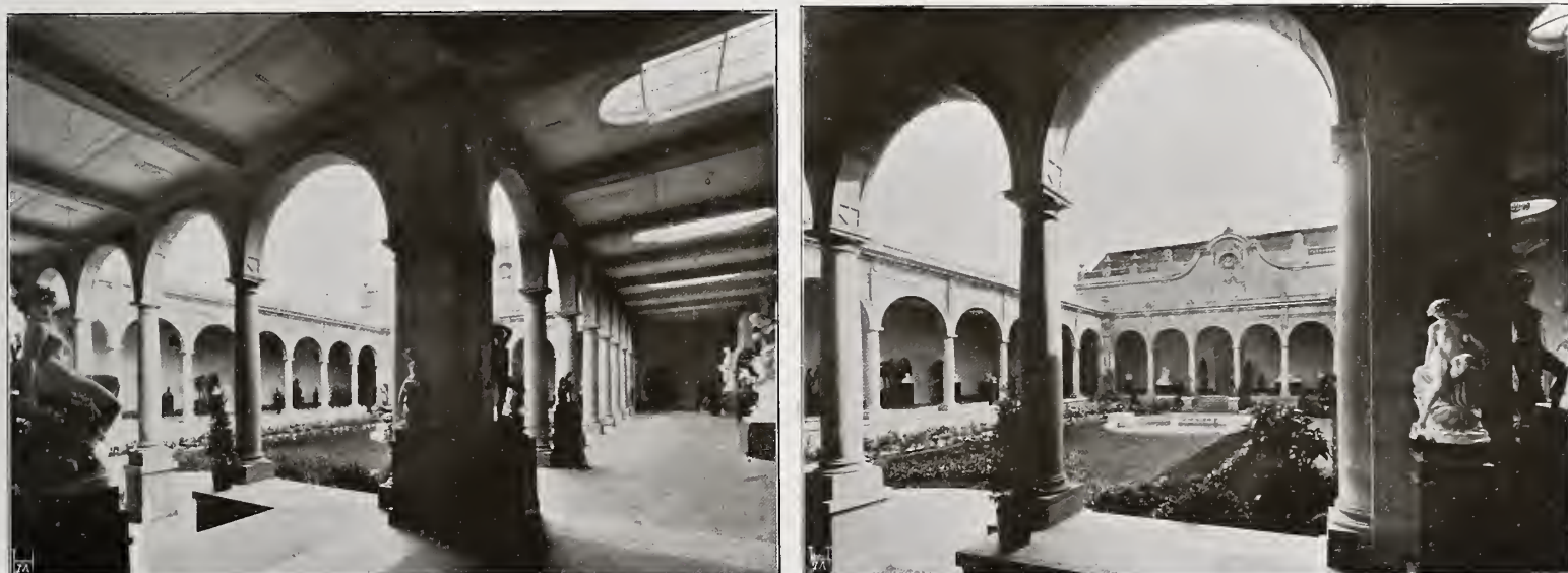
Ehrenhof im neuen Kunstaustellungs-Gebäude zu Düsseldorf. (Nach Aufnahmen von O. Renard in Düsseldorf.)
