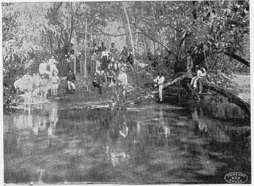
Barra do Ribeirão da Panella
