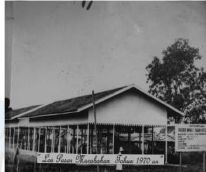
Gambar 3.12 Pasar Marabahan tahun 1970 (Sumber: Kantor Arsip, Perpusda Barito Kuala)
