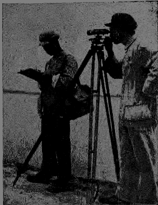
開工修復堤垸前，堤身都經過了精確的鑽探，並進行了清除廢活湖和墓穴等隱患的工作。
