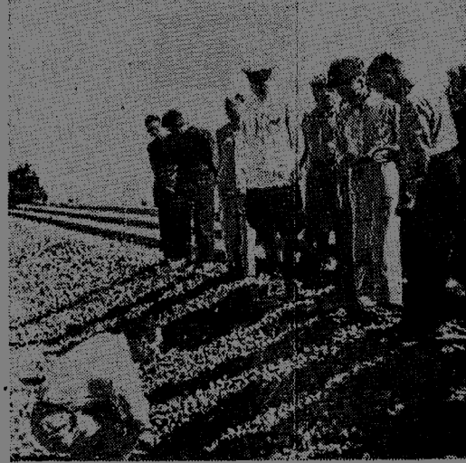
▲ 蘇聯到烏爾巴托的鐵路在我國境內的鋪軌工程，現已鋪到總長二百三十三公里的榜四期車站。今年年底可以鋪到接近我國邊境的二連車站。圖為蘇聯專家在第二號檢查道床和石砟鋪設情況。張信節攝
