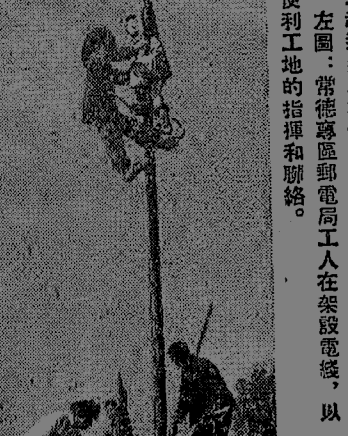
工人支援農民治湖。圖為：常德縣縣府電工人在架設電綫，以便運到工地。
