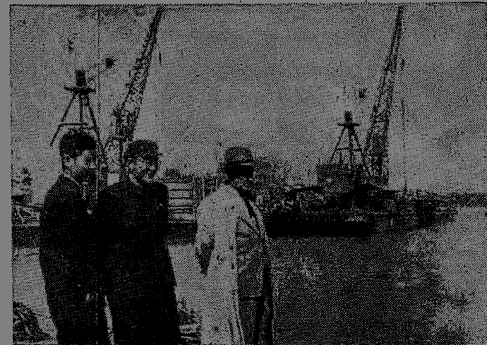
▲ 蘇聯專家奧尼斯科夫經常到漢水鐵橋工地指導和幫助工程的施工。這是奧尼斯科夫(右)和武漢長江大橋工程局局長彭敬(中)等在工地上進行觀察。姚昌溢攝
