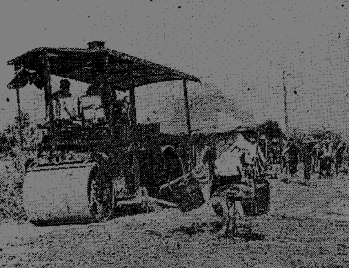
代長沙公路局局長張明天在公路建設現場，向工人們講解公路建設的意義和重要性。背景中可見正在施工的公路和各種工程機械。
