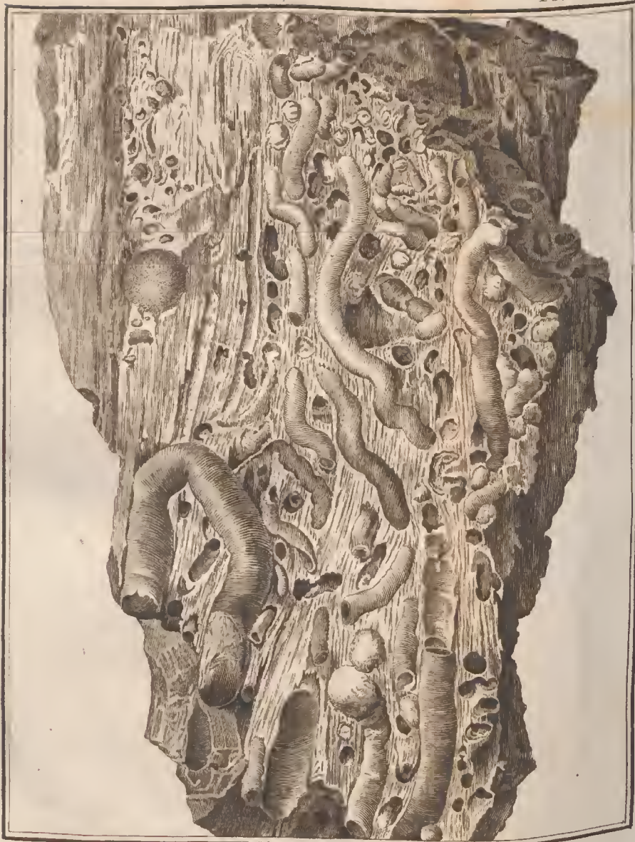
Kraachtig hout van BOORWORMEN doorloord.
