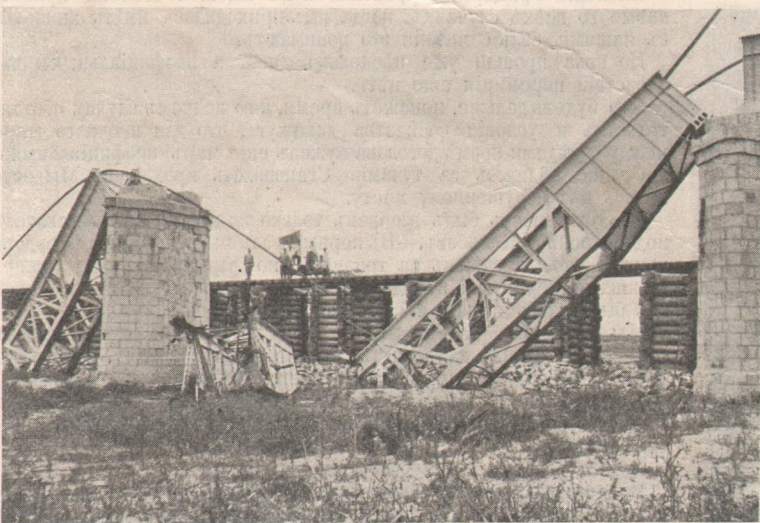
Разрушенный мостъ и рядомъ съ нимъ—возстановленный, деревянный.
