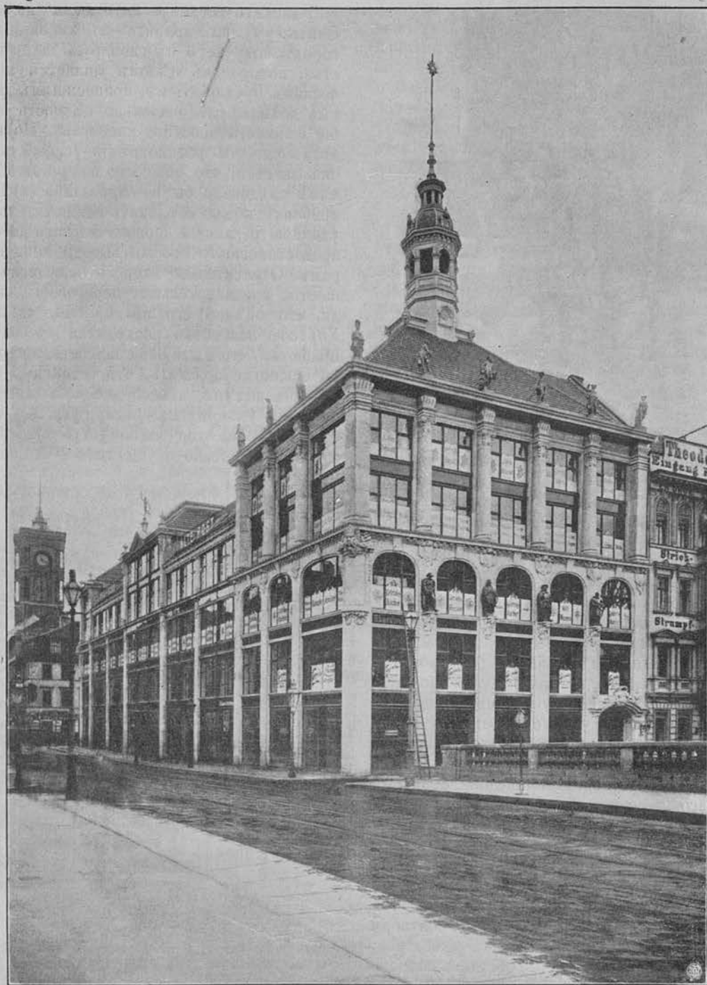
Рис. 27. Домъ на ул. Новая Фридрихштрассе 38—40 въ Берлинѣ. Арх. Р. Шефердъ.
