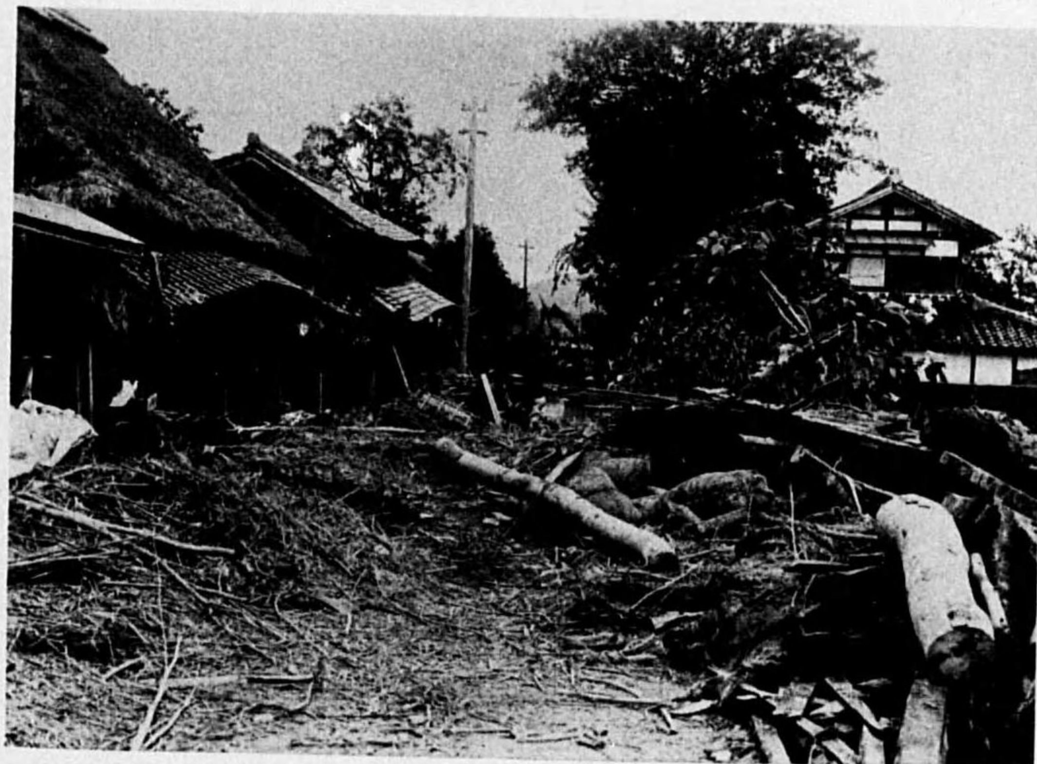
IV 天神川沿線倉吉町内ノ被害
