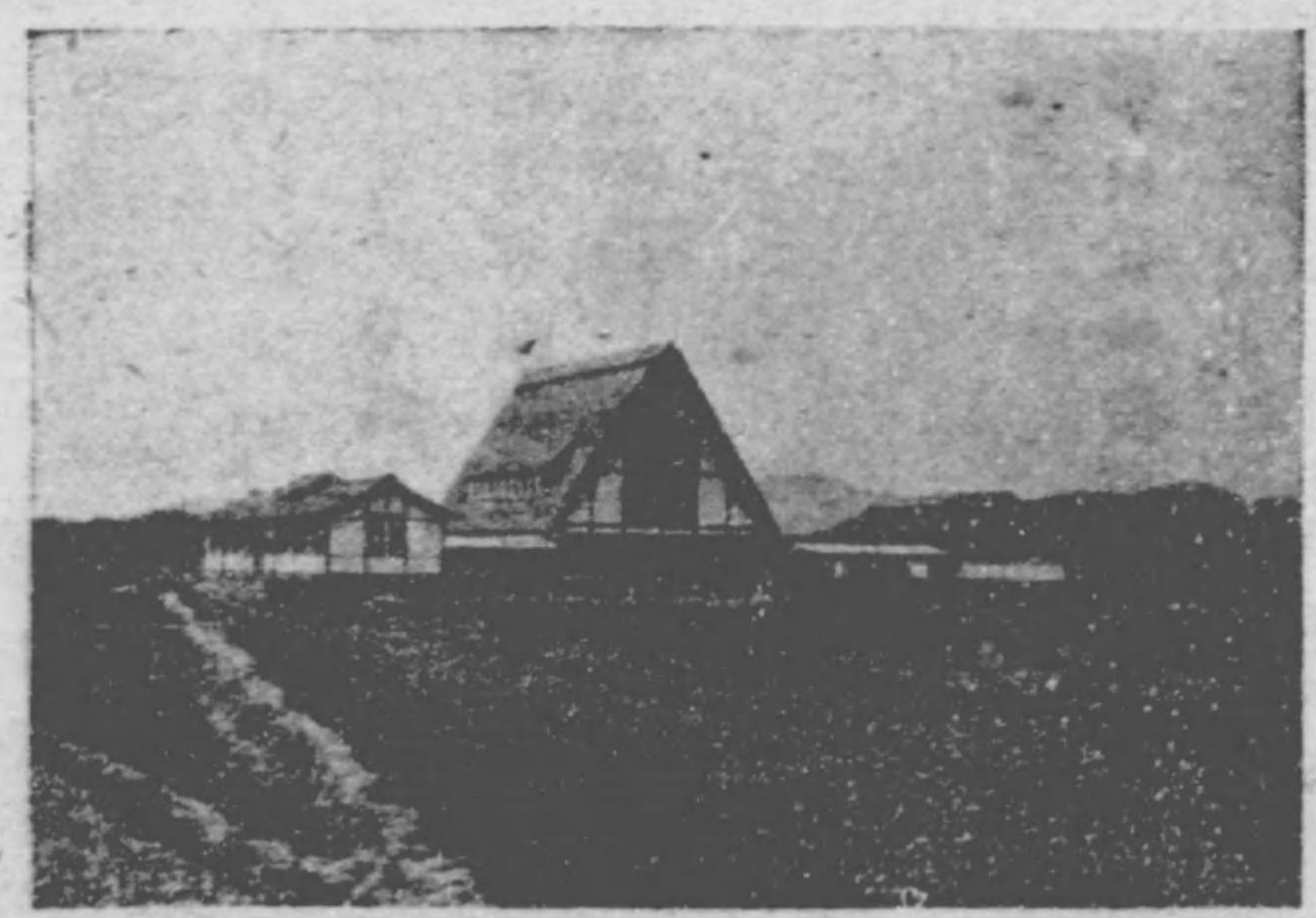
第四十六圖 滿洲開拓幹部訓練所の講堂(天地根元造)と本部
