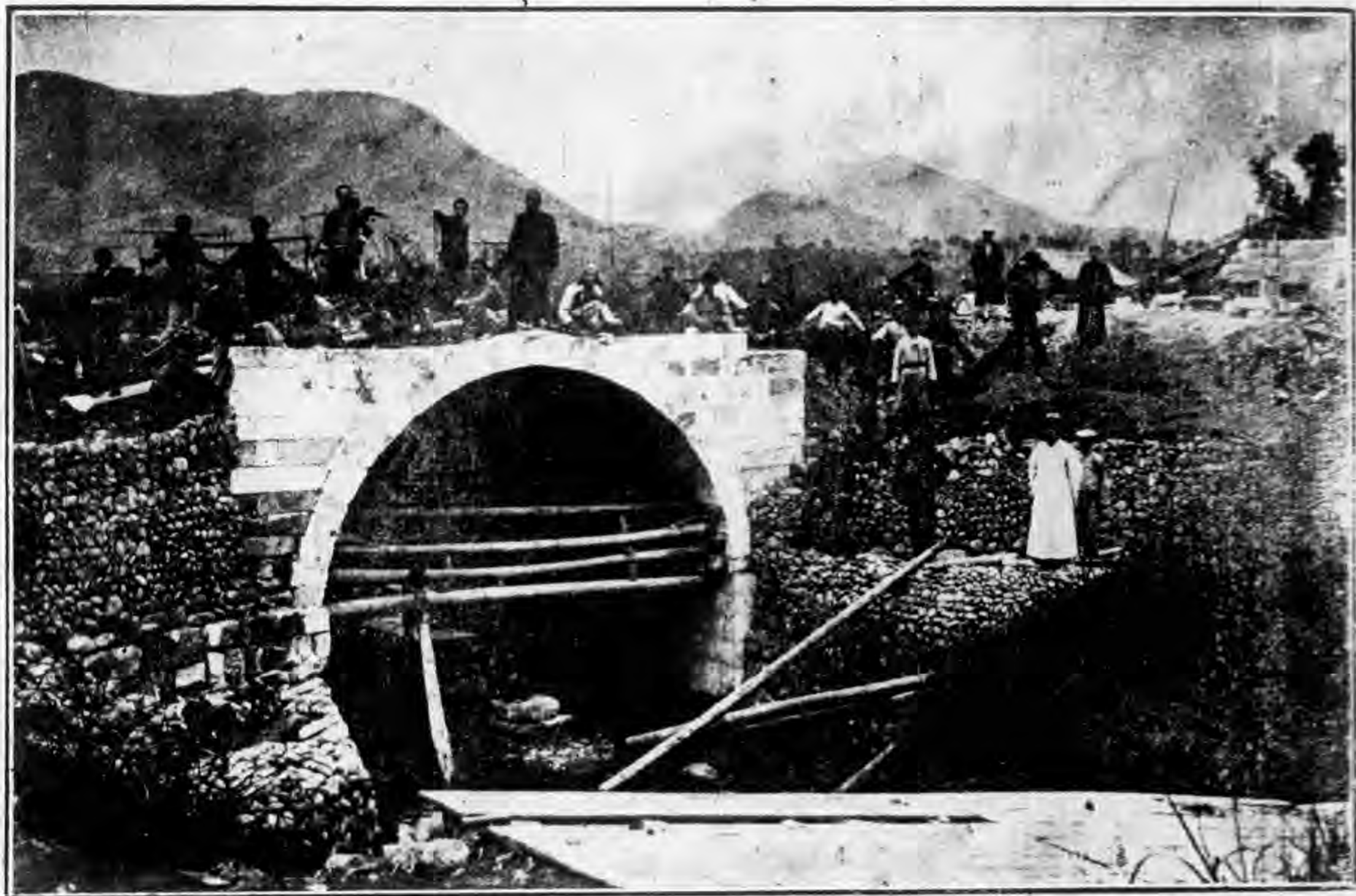
邵光幹路第一段三橋施工時攝影
