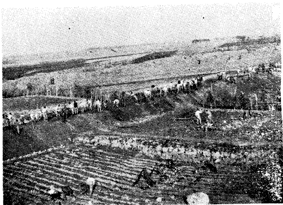
2. 路基構築遠景
