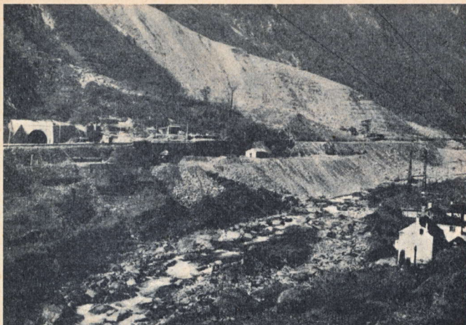
L'entrée sud du nouveau tunnel du Rio Rido, entre Varzo et Preglia Photo ATP
