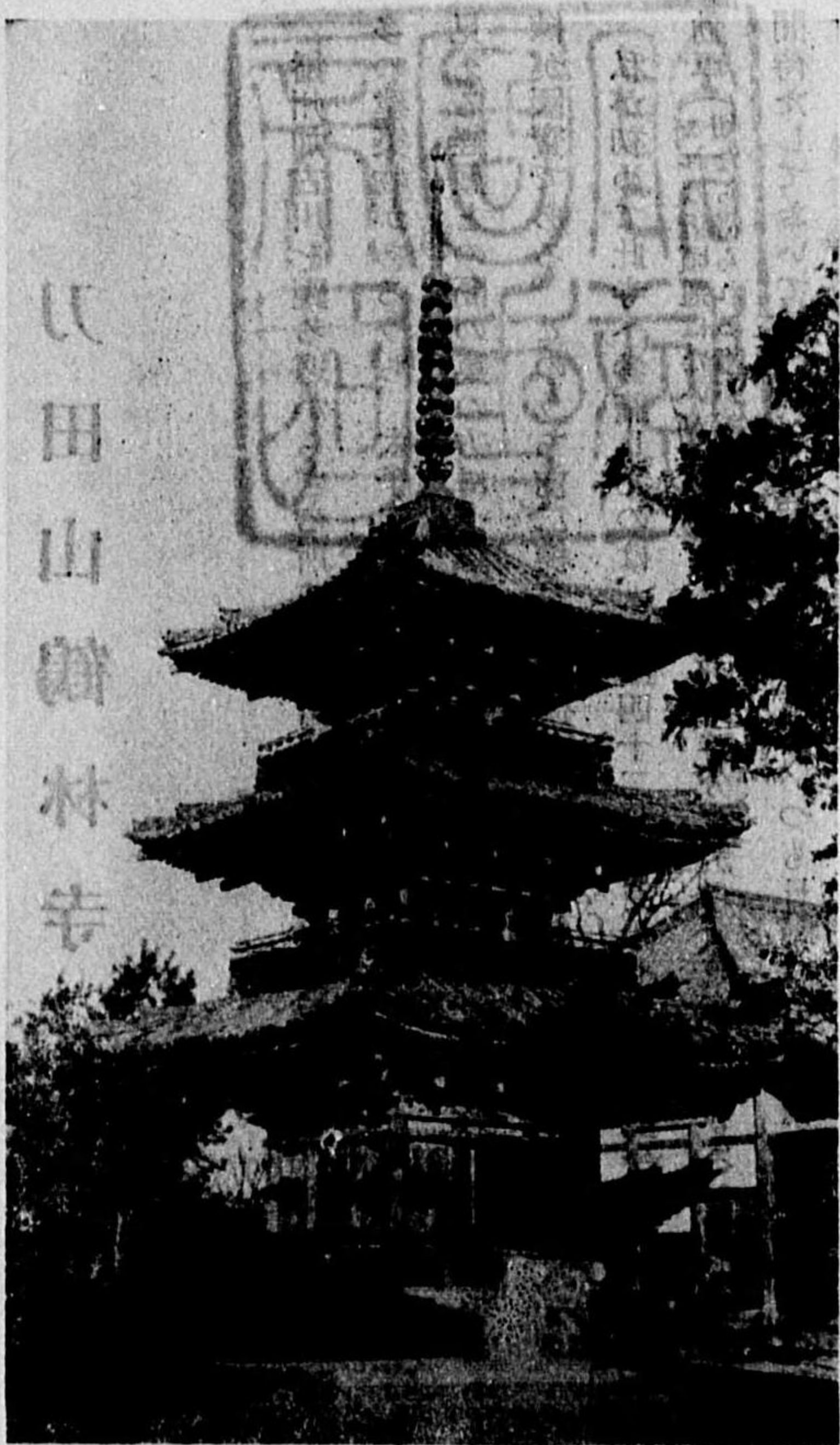
各重の軒先には室町時代と推定し得る瓦も相當に残つてゐる。各重遞減の度も相當に多く、相輪も長大で安定觀の充分な恰好の良い三重塔である。
