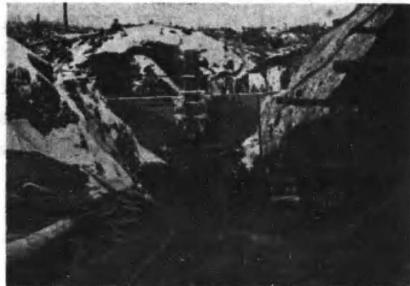
北老松嶺隧道東坑門
