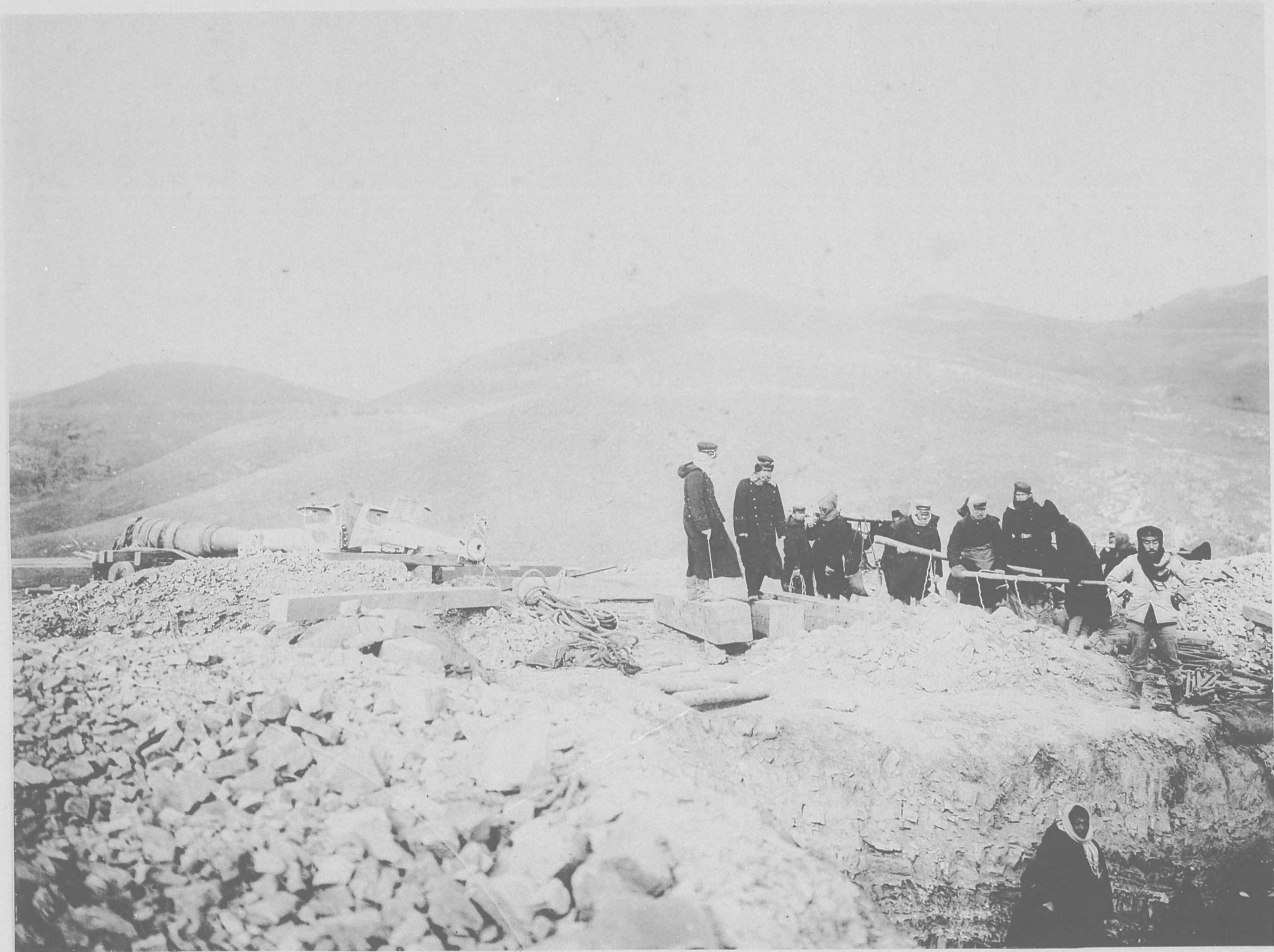
二三百高地附近大溝東地方海軍五十速射砲臺工事ノ光景
