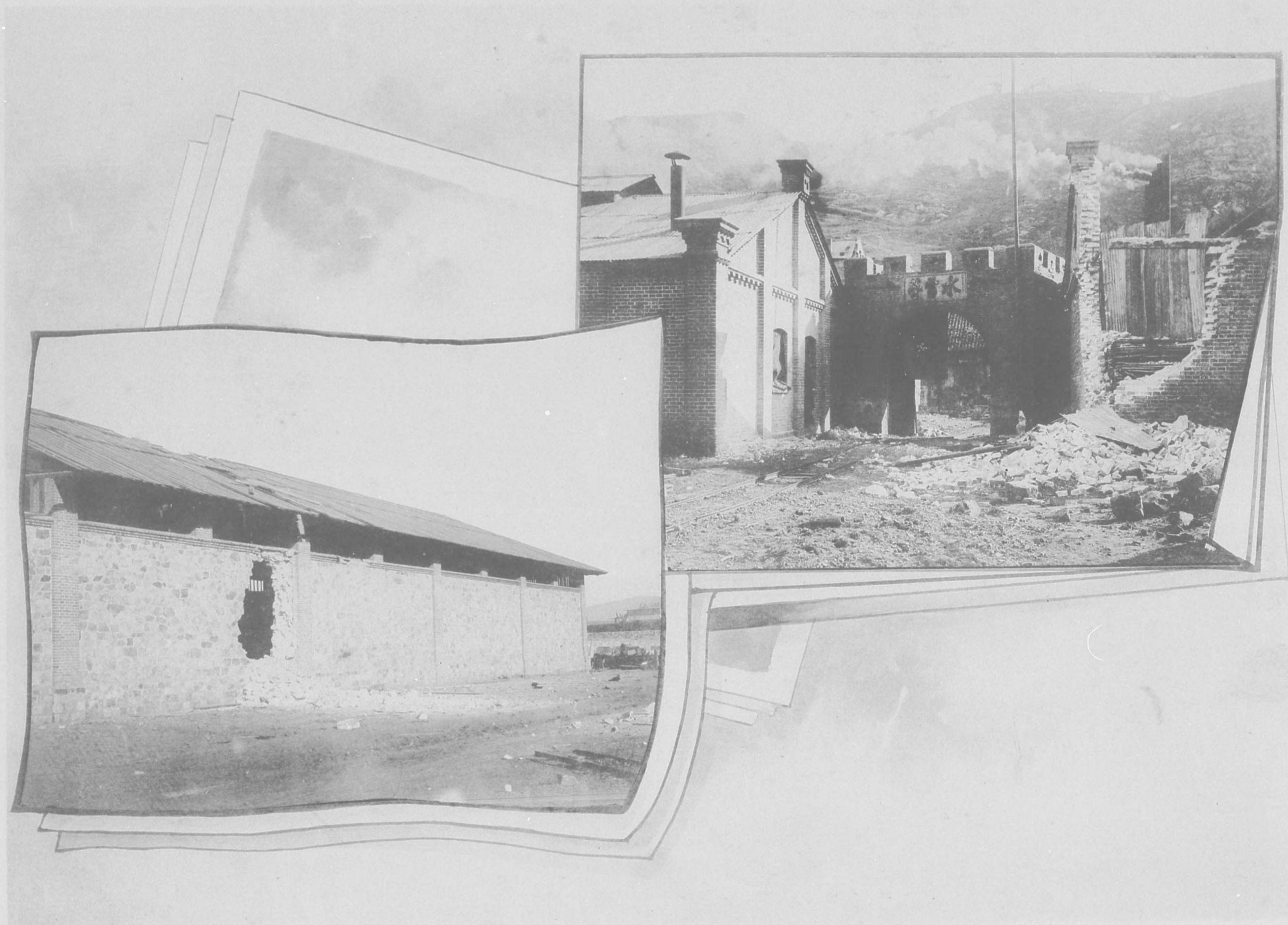
庫炭石ノ前營及營雷水舊ル在ニ岸南港東 (ノモルセ壞破テツ依ニ彈砲我)
