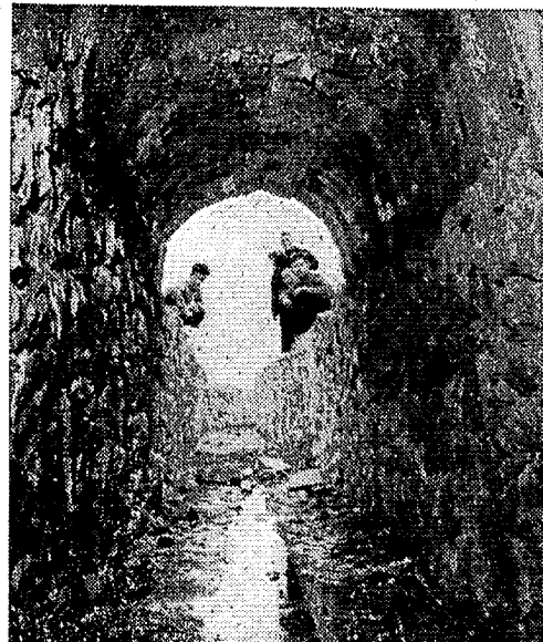
星堂大队贫下中农在党支部的带领下，坚持“自力更生”、“艰苦奋斗”的伟大方针，凭着“一颗红心两只手”，奋战一年，终于打通了这个长五百二十米、高二米二、宽两米的石山隧洞。(本报通讯员摄)
