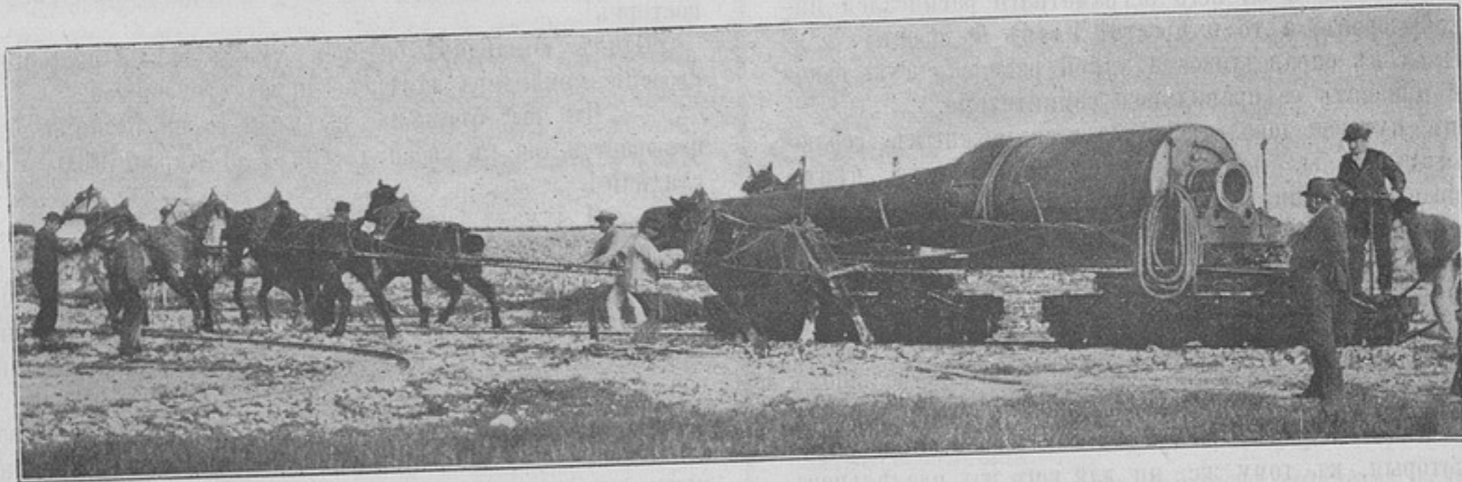
Конная тяга на 60 см. колѣхъ береговой пушки вѣсомъ въ 2700 пуд. (къ рец. «Крѣпости и крѣпостныя желѣзныя дороги»)
