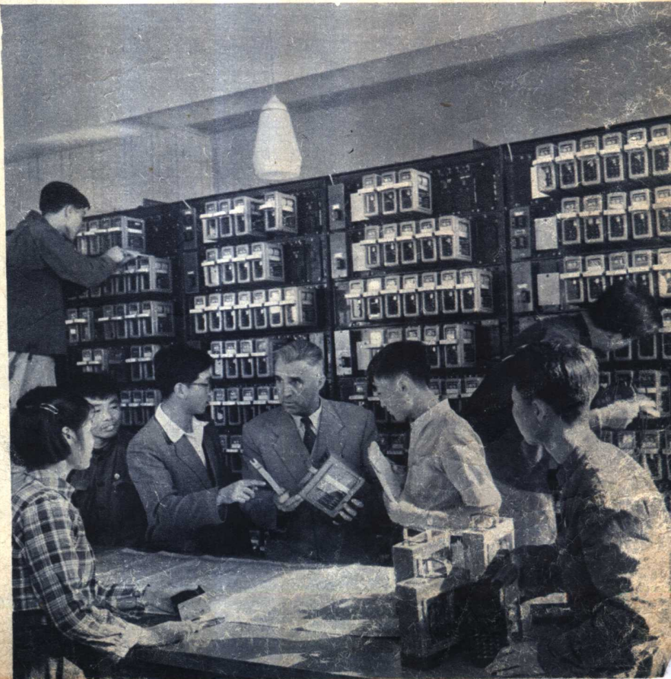
苏联专家别良卓同志在指导安装 电气集中信号设备。
