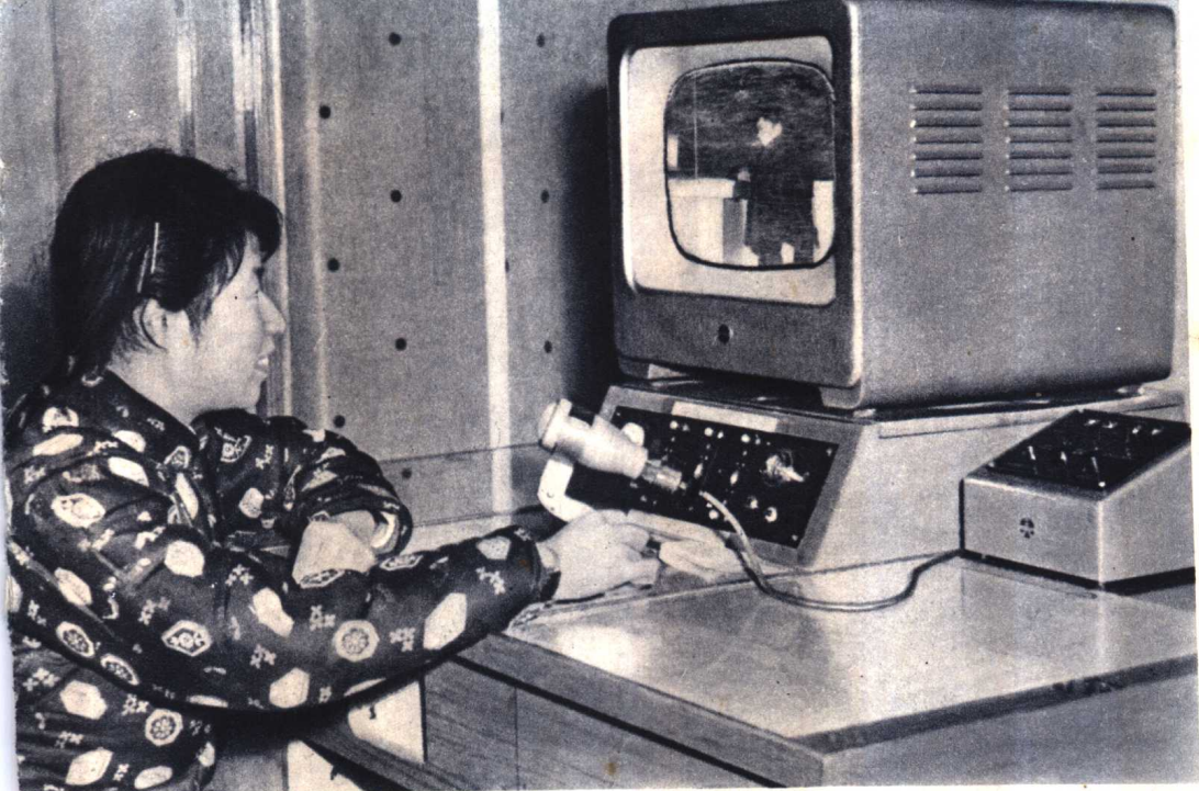
电视问讯室的工作人员，正在答复旅客问讯。
