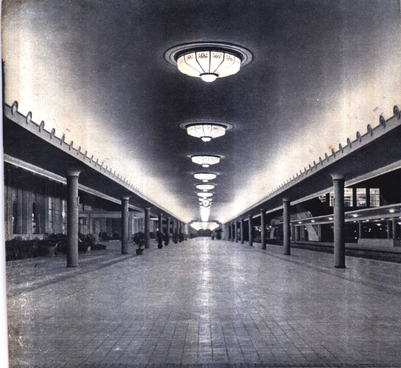
寬 25 米的第一站台，頂棚兩側裝有拍攝電影的 1,600 盞強光水銀燈。
