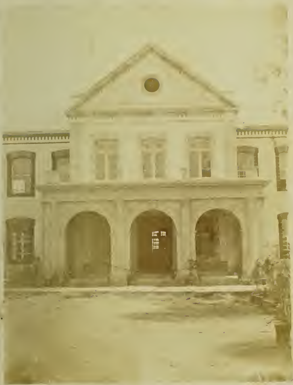
Fachada de la Fábrica de San Antonio.
