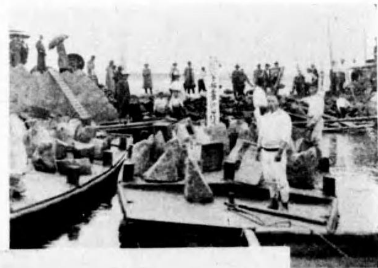
(下) 愛媛縣新居郡西條町船屋耕地整理組合ノ干拓地 (上) 同組合ノ干拓築堤湖留作業
