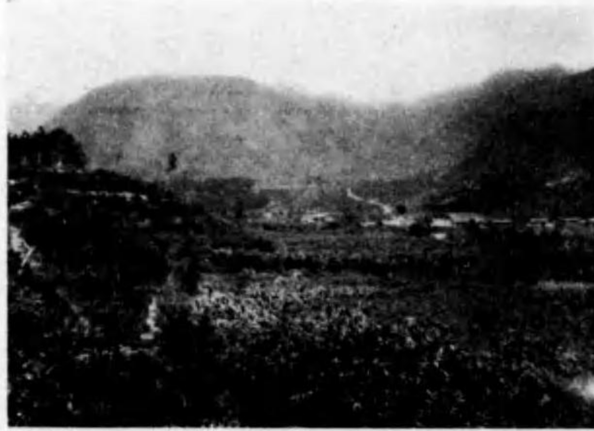
長野縣南安曇郡小倉村築堤豫定地ヨリ池敷ヲ望ム
