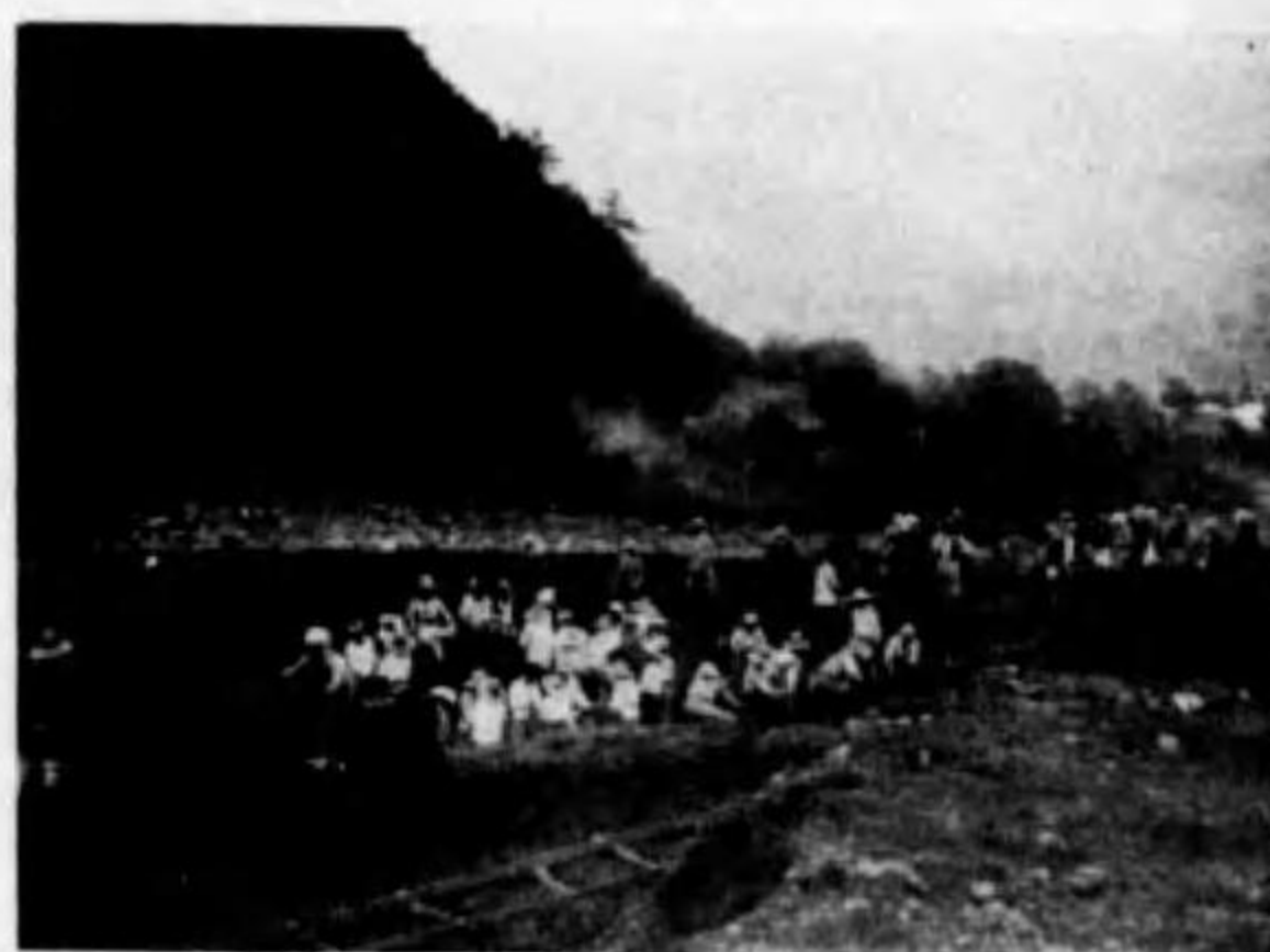
(右) 山梨縣北都留郡大原村小笹耕地整理組合 溜池堤塘工事 (左) 同工事ニ於ケルM E式土締機ニ依ル堤塘 搦固作業
