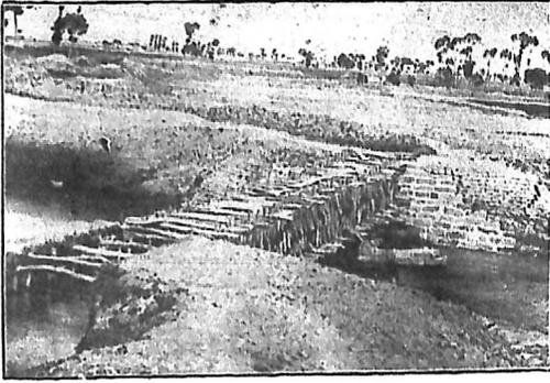
① 惠農渠上架設之菓子渠（漢延渠支渠）飛槽
