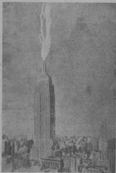
第五〇圖 這是美國紐約的帝國大廈。為世界最高的摩天樓。當雷電來到的時候，並沒有危險。因為大廈是用鋼骨水泥砌的，有避雷的作用，且能保護周圍較低的屋房。
