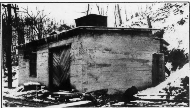
FIG. 6. GRAHAM FAN HOUSE
