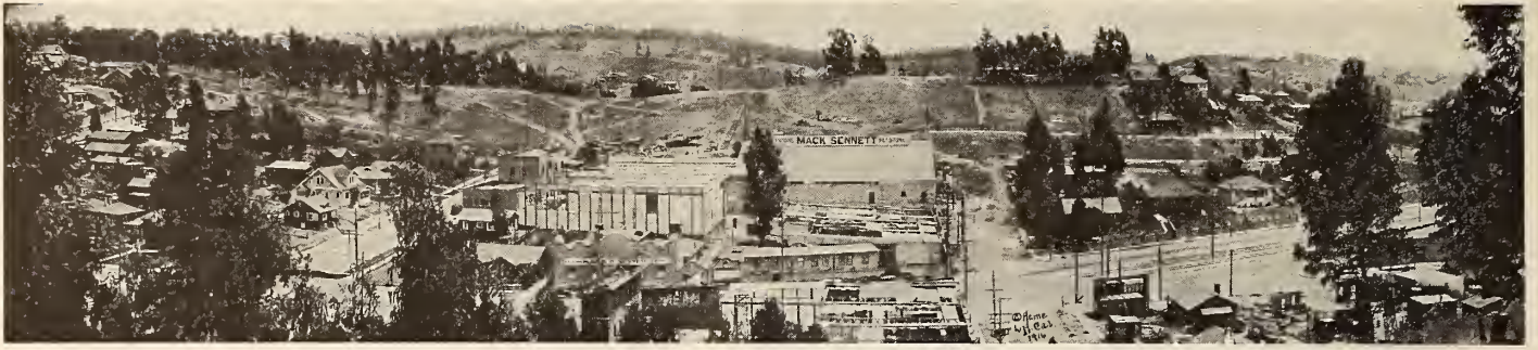
Vista general de los laboratorios y talleres de la Empresa KEYSTONE en Los Angeles, California
