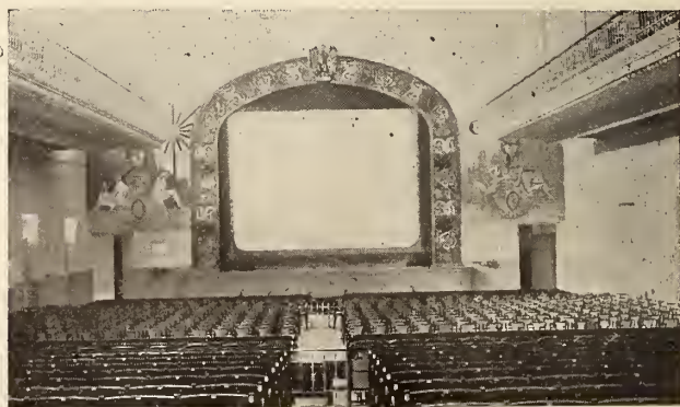
MADRID.—"Cine Ideal," de reciente construcción.
