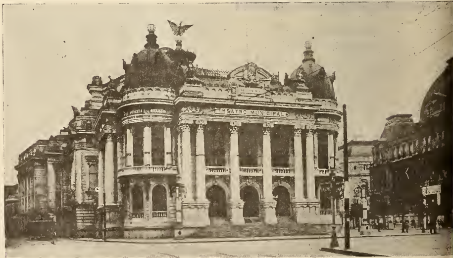
O Theatro Municipal de Río de Janeiro, um dos primeiros installados nessa capital.
