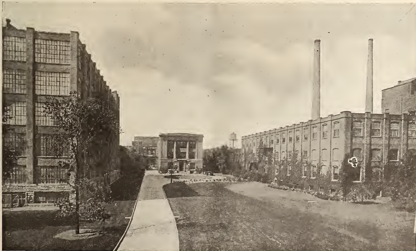
Vista parcial de los talleres de la Eastman Kodak en Rochester, Estado de Nueva York.
