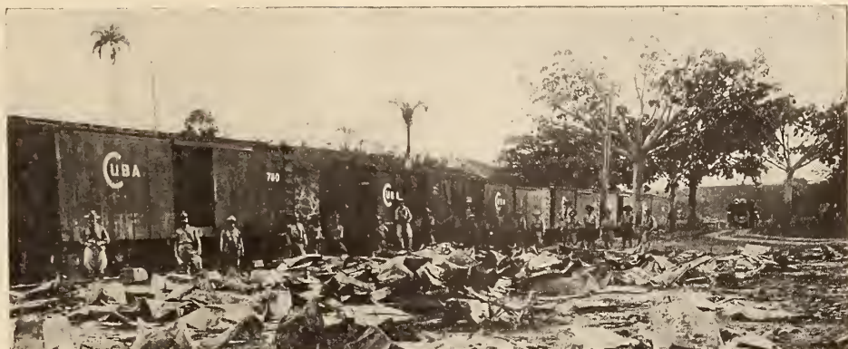
Estación de ferrocarril de Songo (Oriente-Cuba) destruída por los rebeldes.
