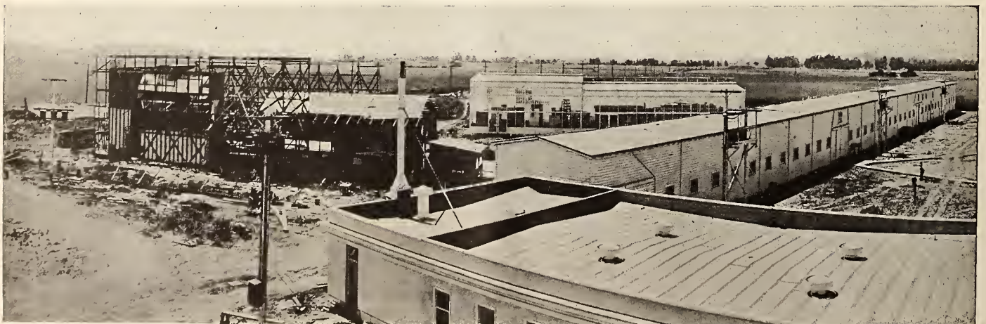
Vista panorámica de los talleres recientemente edificados por el director Thos.
