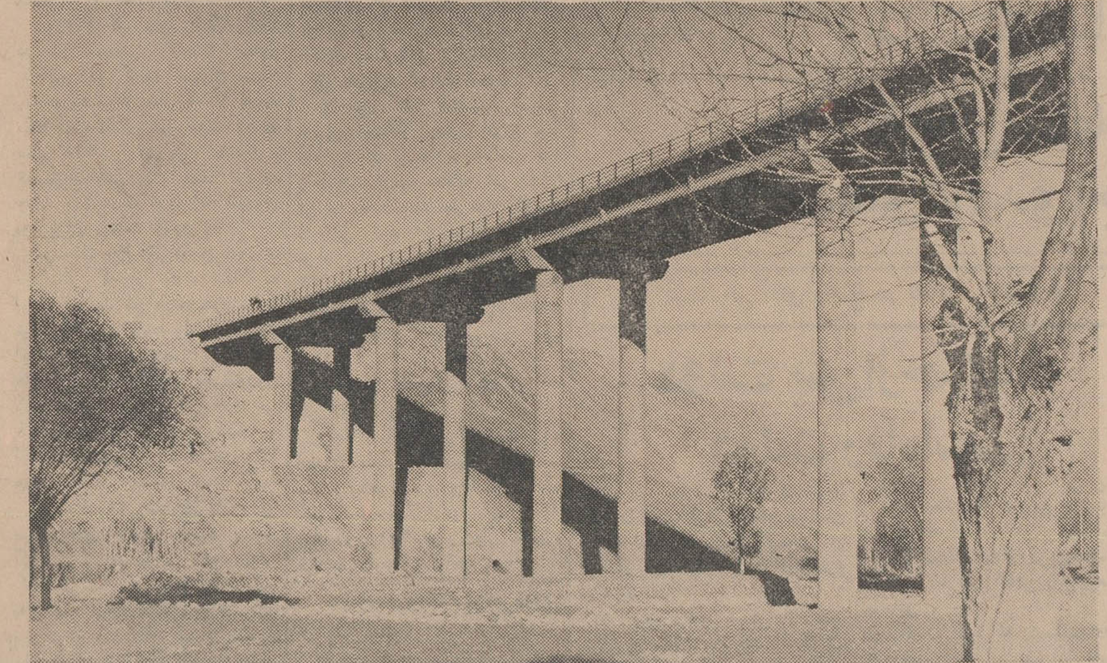
یک نمونه از جدیدترین پلهائی که در مسیر راه ساخته‌شده و با ساختمان همین پل گردنه شبلی متروک گردیده‌ودردسر پایان‌ناپذیر گردنه از میان رفته است
