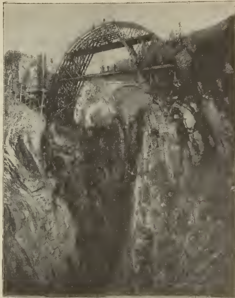
EL PUENTE MÁS ALTO DEL MUNDO: LOS VIADUCTOS DEL FERROCARRIL EN LA GARGANTA DE ALBULA
