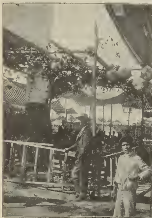
Bañolerías y cantinas
