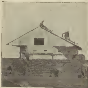
CONSTRUCCIÓN DE UN BLOCAO. - El blocao terminado
