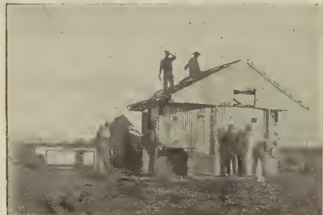
CONSTRUCCIÓN DE UN BLOCAO Aspecto del blocao en el segundo día de su construcción
