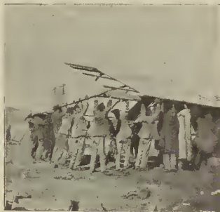
CONSTRUCCIÓN DE UN BLOCAO Colocación del techo
