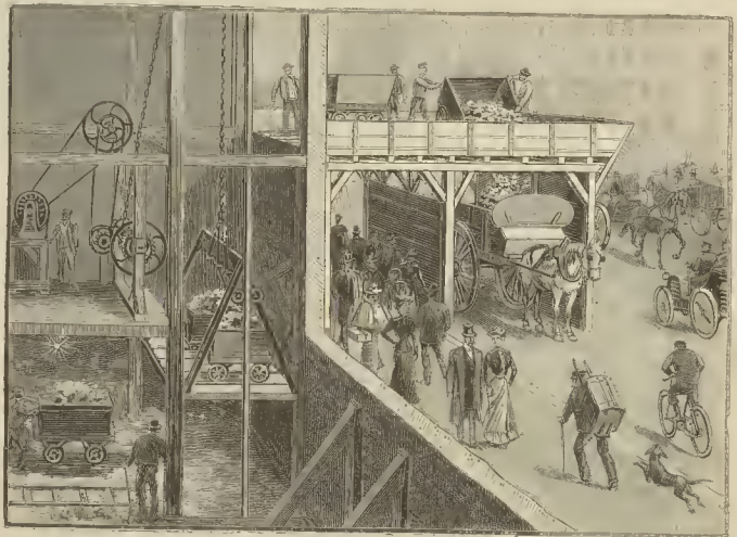
Fig. 3. - Cabria de maniobra de las vagonetas. - Estacada que cubre la acera y una parte del arroyo para la carga de los chirriones
