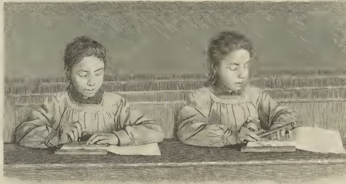
Fig. 1. - Aparato para escribir y calcular los ciegos. - La niña de la izquierda escribe con su punzón y la de la derecha tiene levantados el punzón y la regla que le sirve de guía
