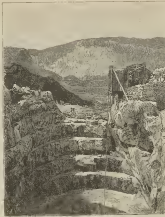
Fig. 3. - MINAS DE SAL DE CARDONA. Explotación por medio de pozos a cielo abierto
