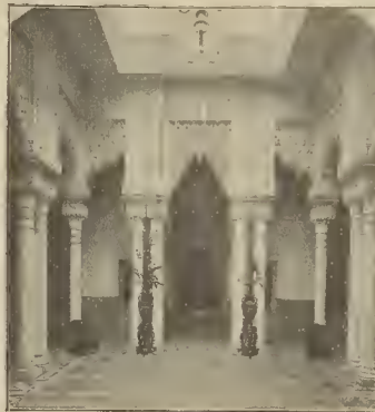
PALACIO ÁRABE. - CASA DE BAÑOS Vestíbulo del primer piso
