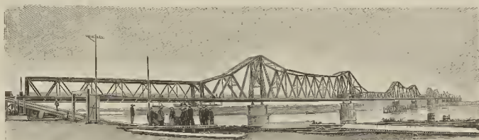
El nuevo puente monstruo del ferrocarril de Hanoi
