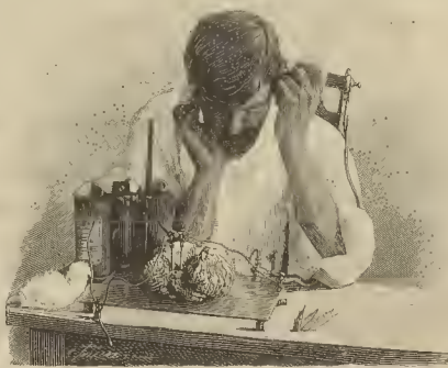
Fig. 2. - Recepción de las señales por medio de un colector de ondas compuesto de dos agujas clavadas en un cerebro
