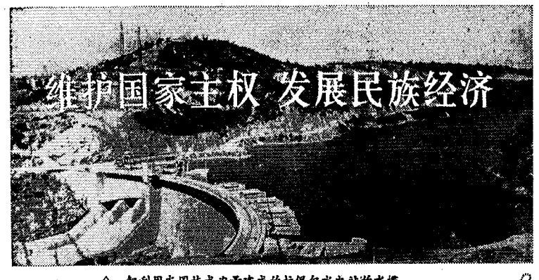
利用本国技术力量建成的拉佩尔水电站的水坝。
