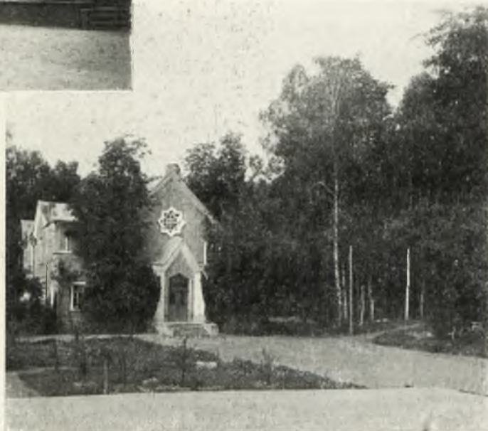
Каменный домъ въ Губокомъ (уцѣлѣлъ отъ пожара).
