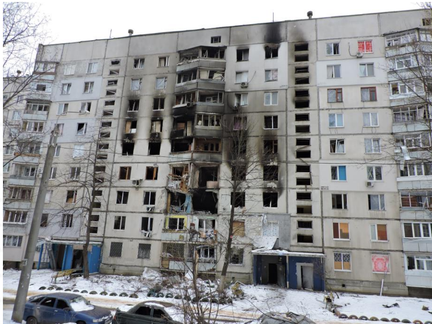
Пошкоджений будинок на Східній Салтівці, березень 2022 року. Фото: Kharkivian, CC BY-SA 4.0
