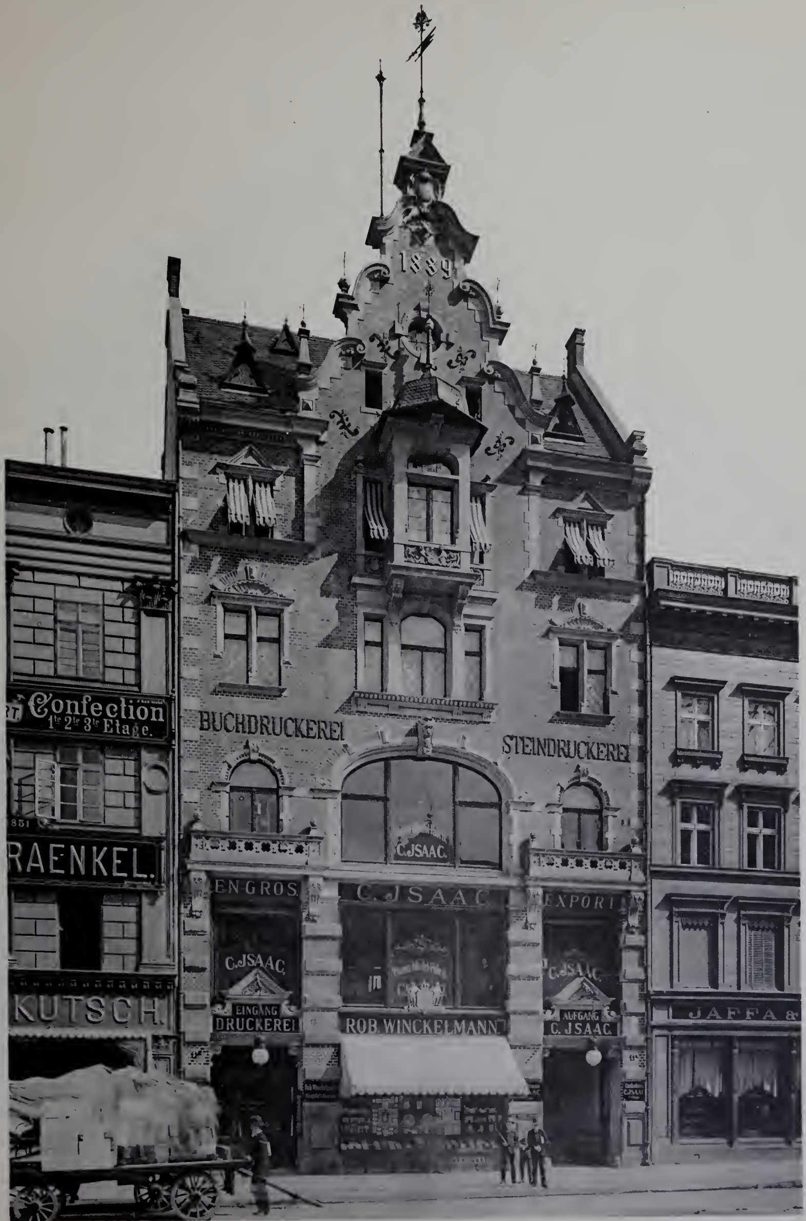
Architekt: E. Peters.
