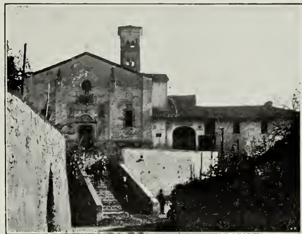
Fig. 101 - Chiesa di S. Teonesto in Masserano.
