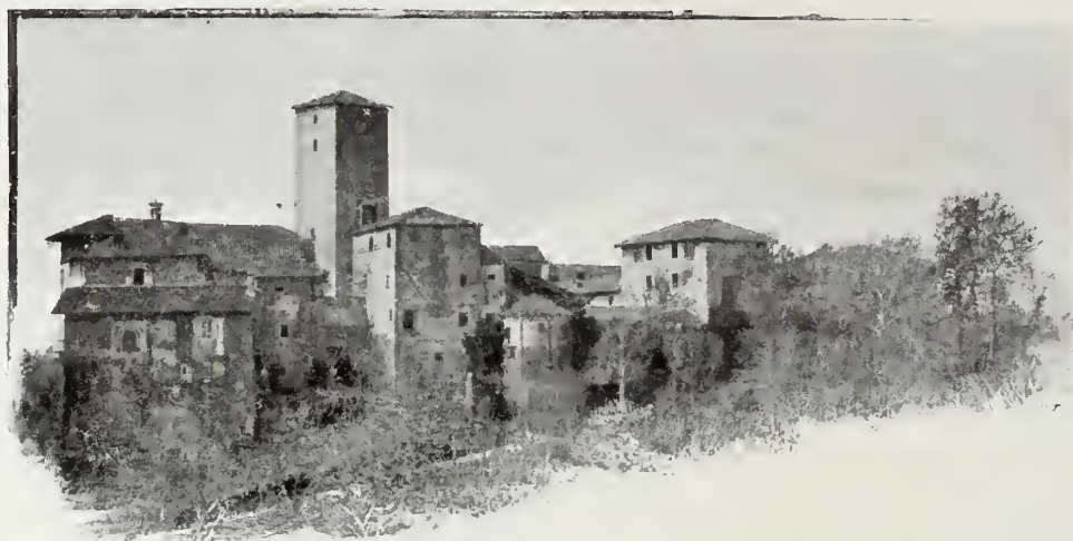
Fig. 127 - Castello di Massazza (lato nord).
