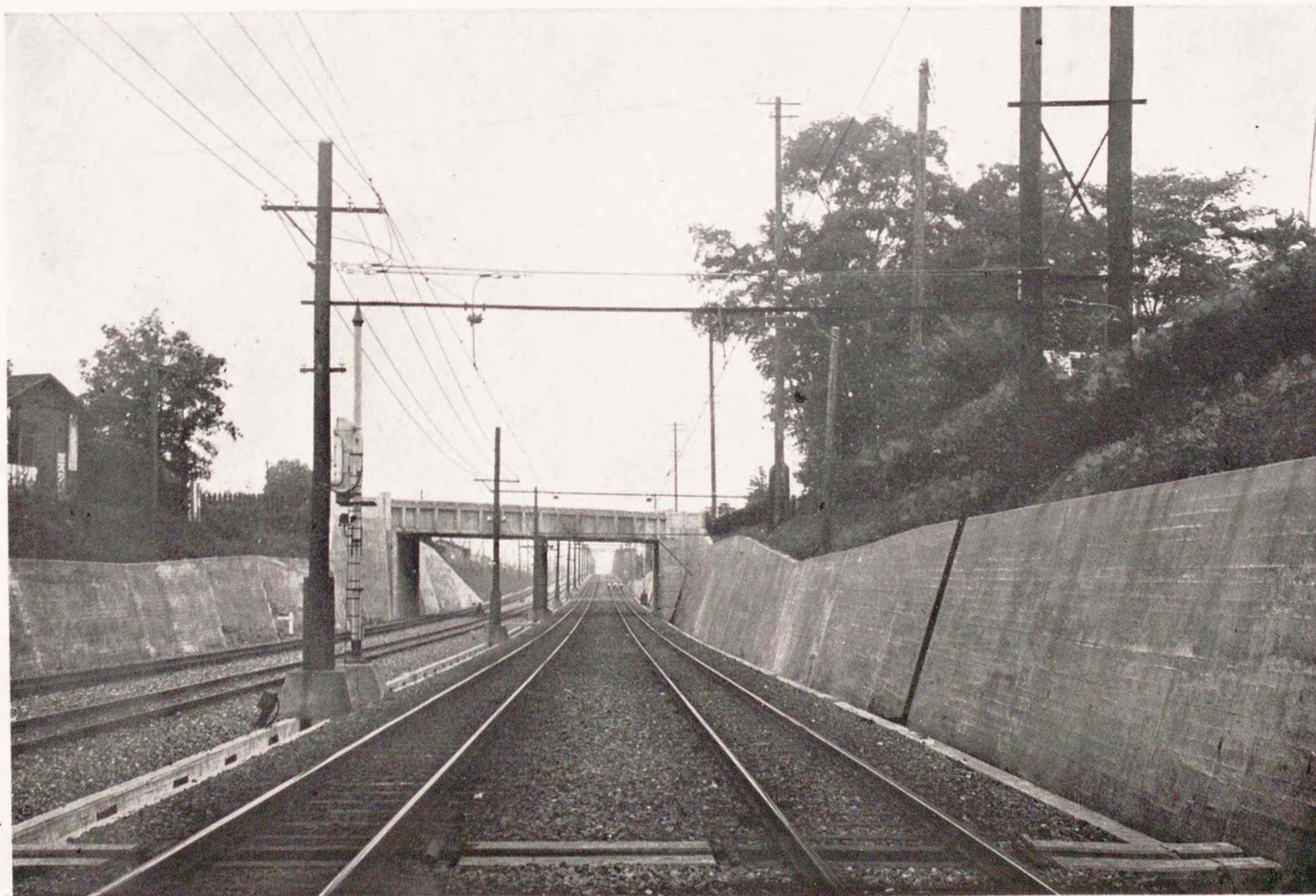
浦和大宮中間仙道跨線道路橋
