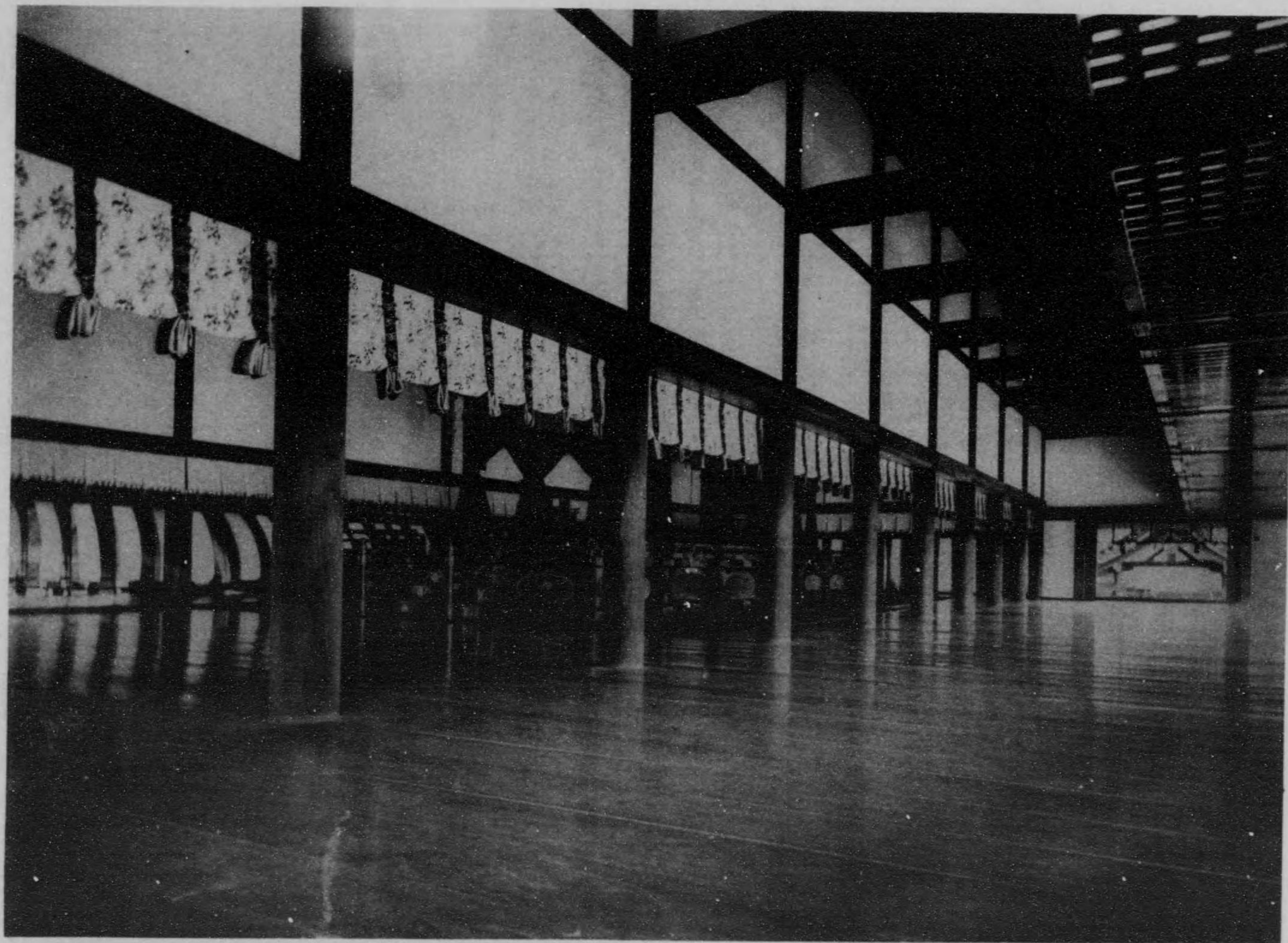
三はに央中の殿、し渡き引を額相の像日るたひ楯を雲端の彩五はに紫南の殿日此。たふ給せさげ舉を儀大の位即御て於に殿宸紫、下陸上聖しく長は日十月一十。 す拜を臺帳御の座御下陸后皇はに東の座御高。る垂く深帳御、し安奉を座御高の婚玉鳳金に上の壇欄塗黒の没
