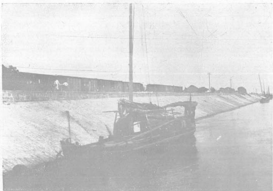
督修六合溝卸煤處石坡工程之攝影
