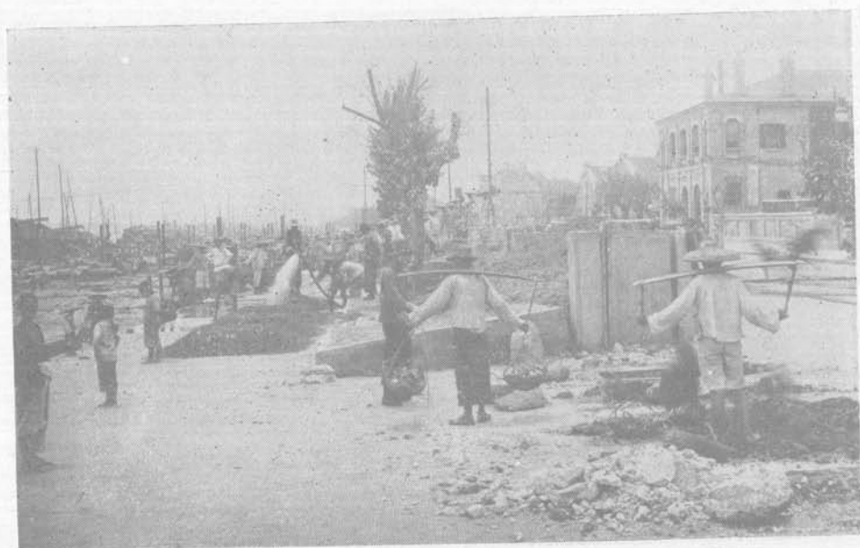
沿堤滑坡鋪設黃土及閘柱脚掘土之攝影
