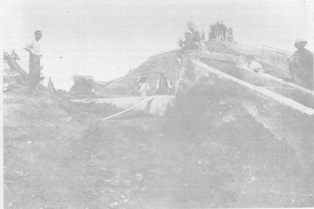
影 攝 二 之 堤 土 爐 金 分 築 建
