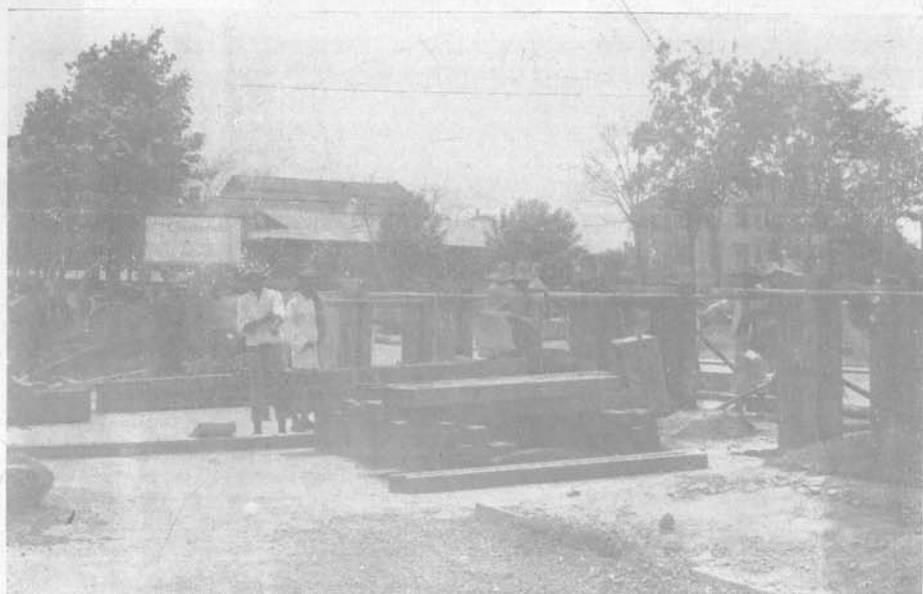
影攝之作工柱閘架試後成完堤
