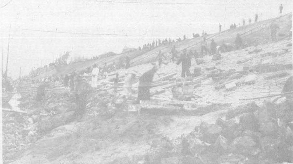
影 攝 一 之 堤 土 爐 金 分 築 建
