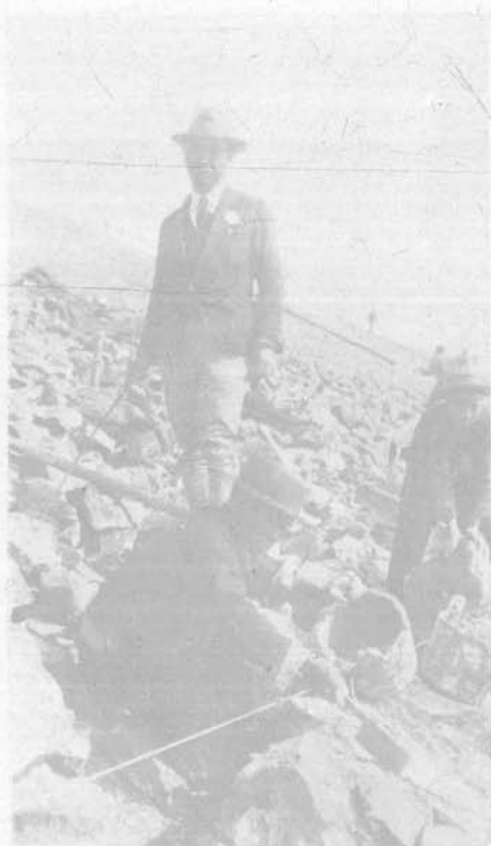
影攝之程工坡滑爐金分築建
