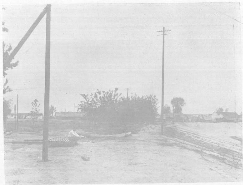
影 攝 十 之 堤 土 爐 金 分 築 建
