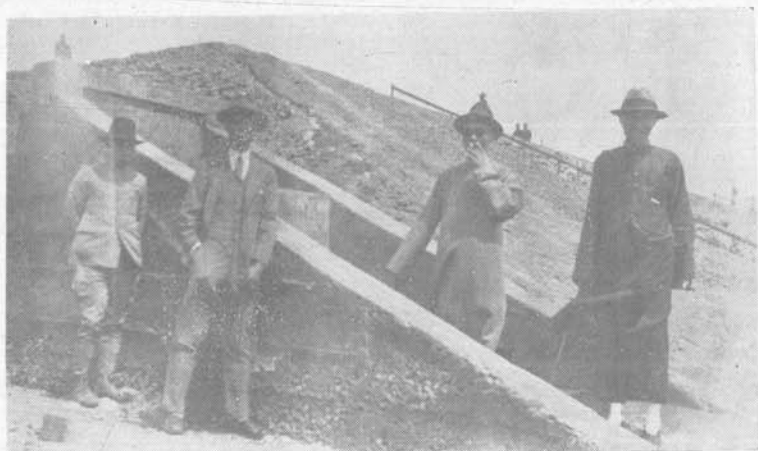
新 建 分 金 爐 涵 洞 口 攝 影
