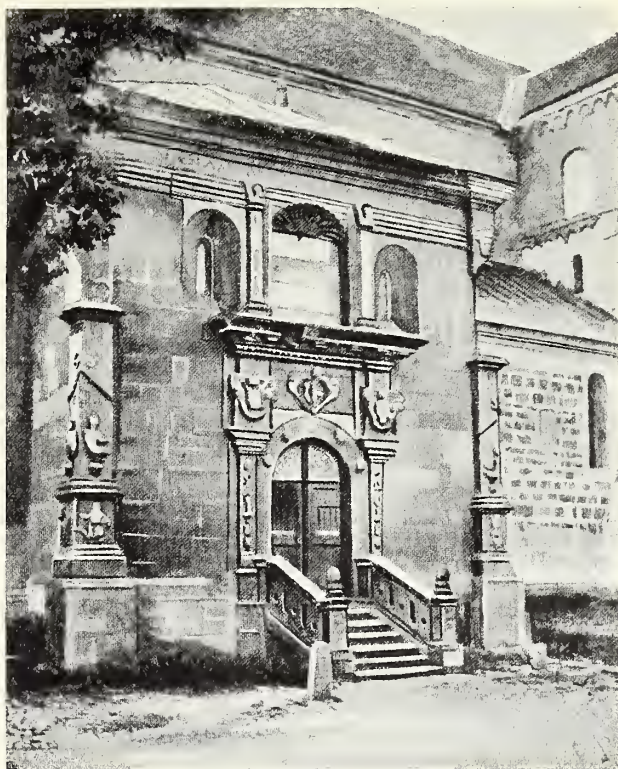
357. kép. A gyulafehérvári székesegyház renaissance előcsarnokának homlokzata.
