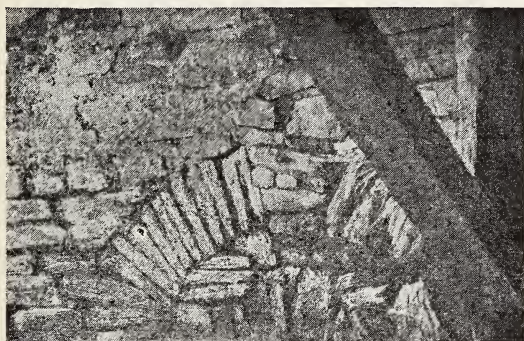
Fig. 162. Rest des südlichen Hochfensters in der Westmauer des Petersturmes.
