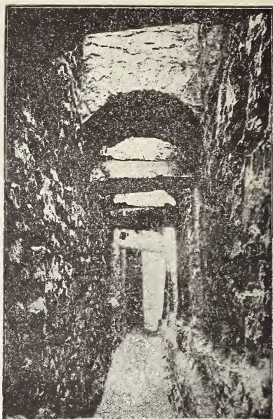
Fig. 52. Blick in die Strebebögen-Anlage. (Von Ost nach West gesehen.)
