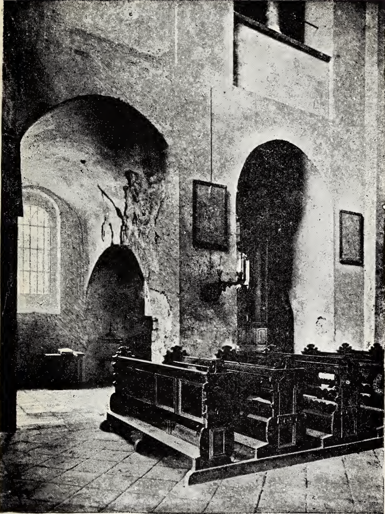
Blick in die Tonnengewölbe des nördlichen Seitenschiffes der Peterskirche. Von Südwest.
