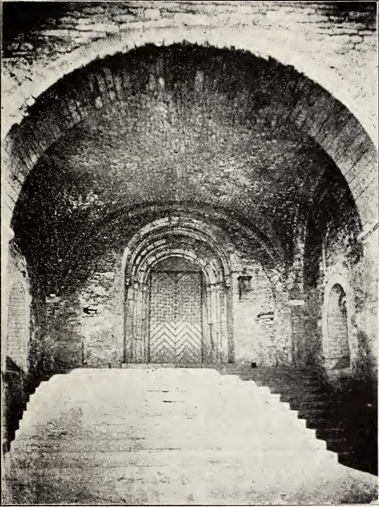
Fig. 253. Innere Ansicht des Paradieses vor dem im Jahre 1894 erfolgten Abbruche des Portals, des Gewölbes und der Treppe.
