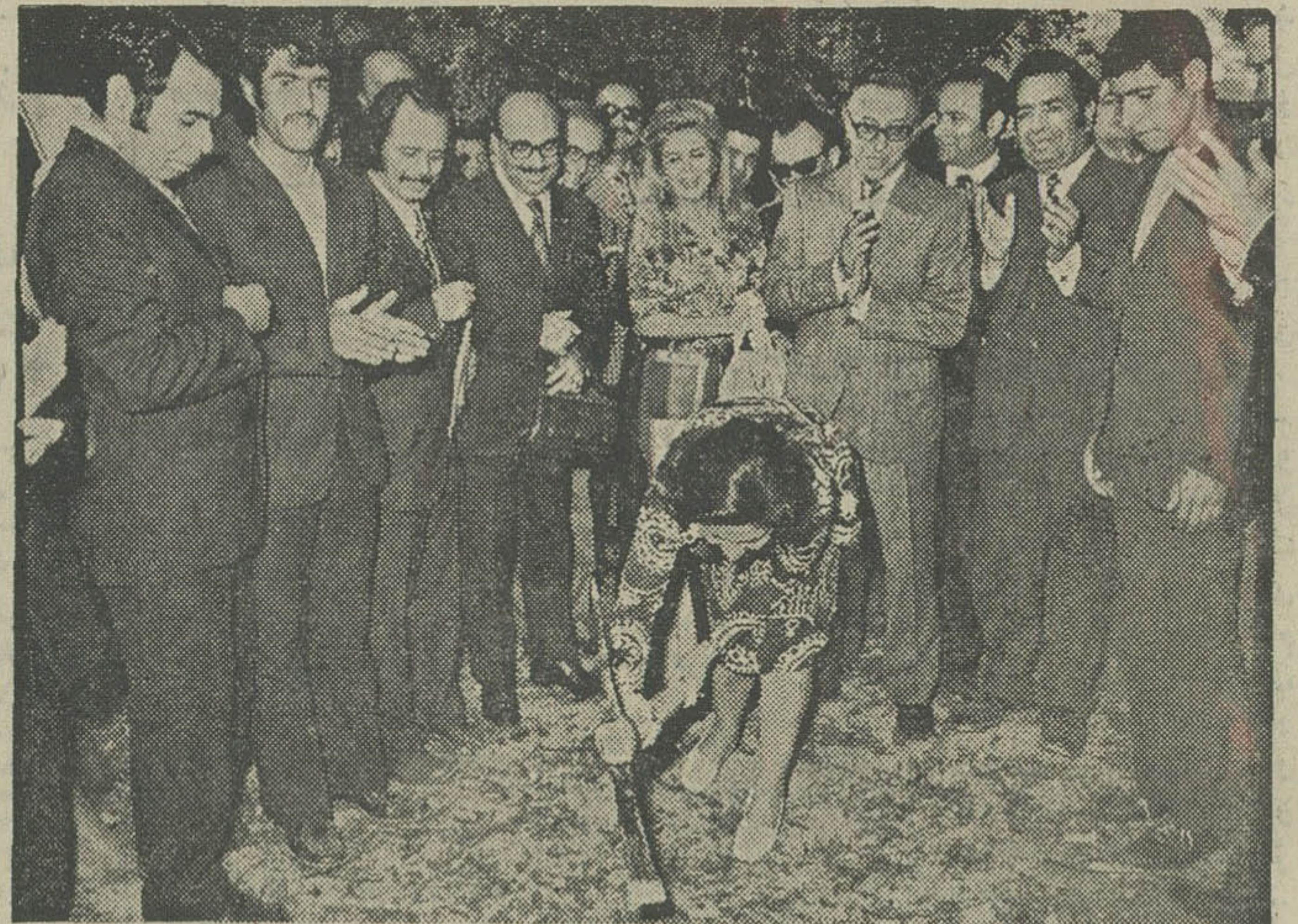
اولین کلنگ ساختمانی پارک جنگلی رستمپور توسط خاتم مهندس روحانی وزیر کشاورزی و آقای استاندار و وزیر کشاورزی و جمعی از مقامات دیگر دیده میشوند.
