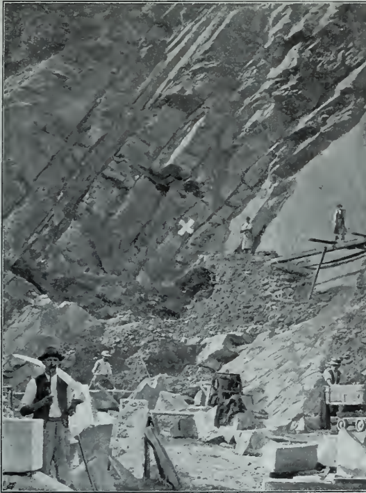
Der Steinbruch des Herrn Leopold Nussbaumer in Pinsdorf.
