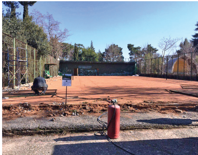
Демонтаж тенісного корту в Лівадії під встановлення пам'ятника цареві Олександрові III. 09.03.2017 р.
