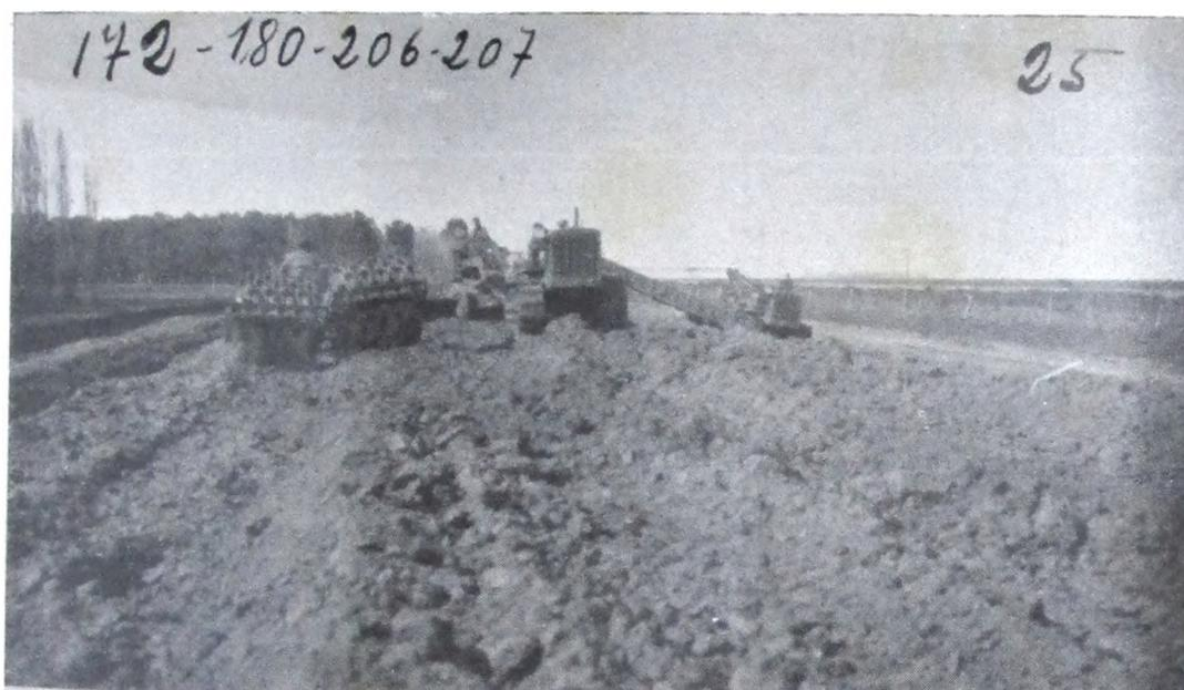
Vista de los «Pata de Cabras», niveladora y elevadora en ejecución, en terraplén.
