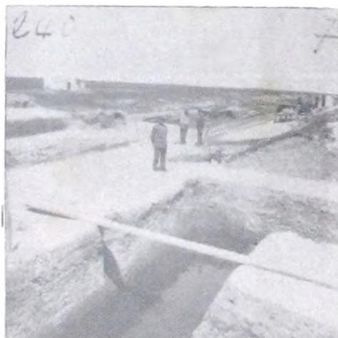
Excavación fundación puente hormigón armado, 3 tramos de 15,000 m. de luz c u, sobre canal N° 11.
