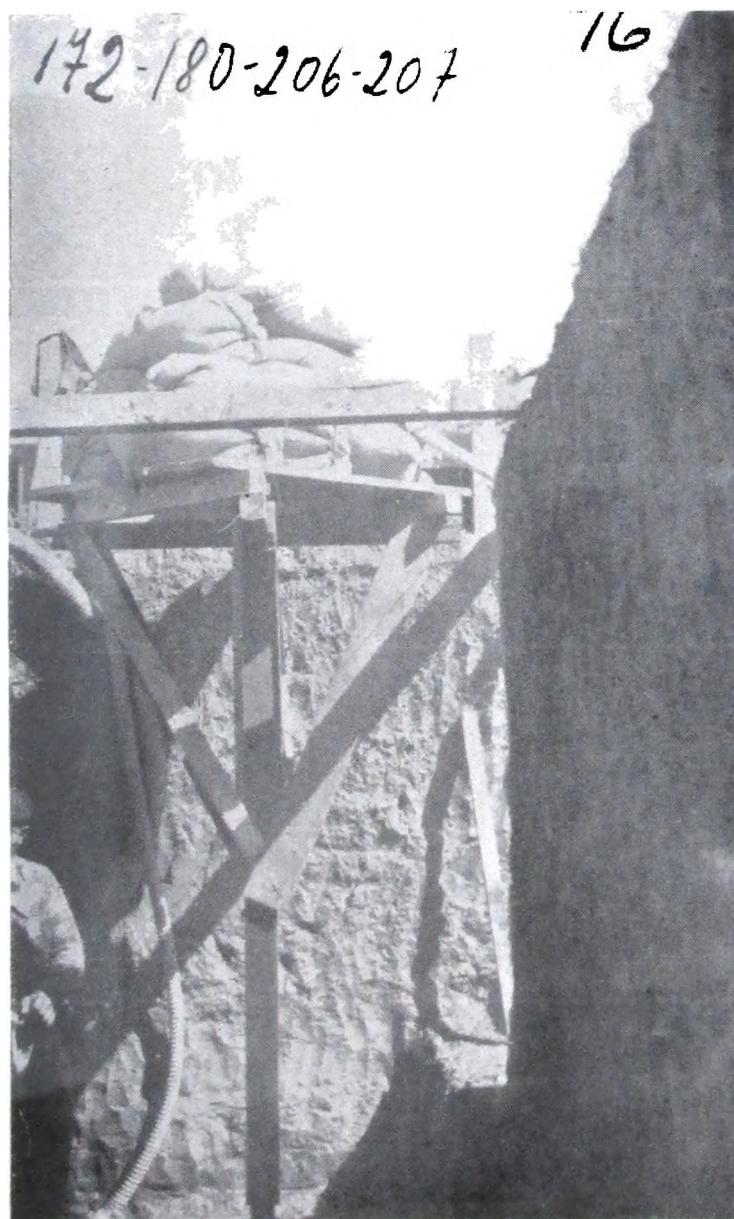
Vista prueba de carga para determinación de resistencia del terreno.
