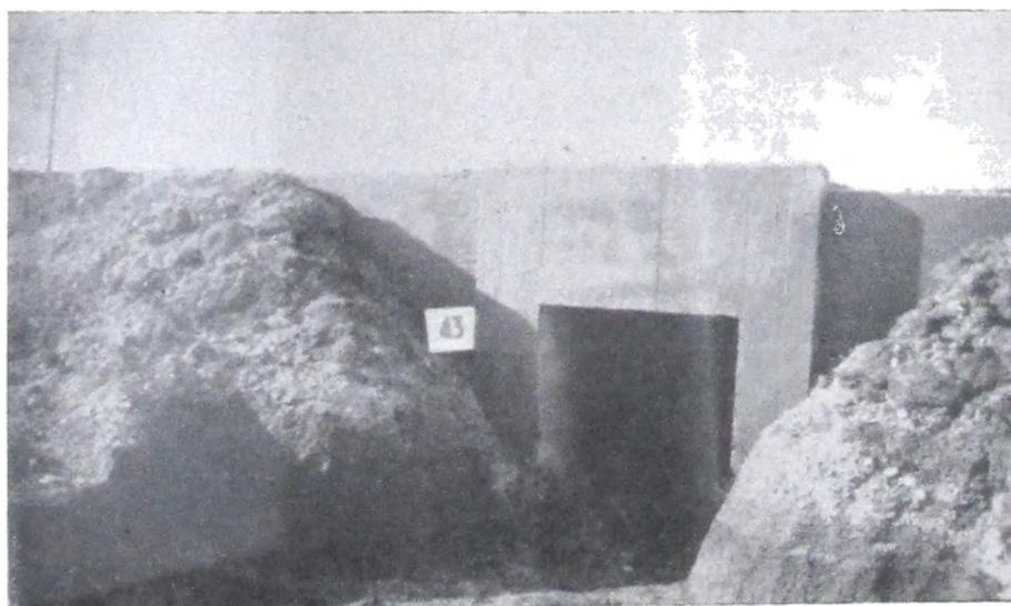
**Cabecera alcantarilla N° 61 de hormigón armado, de una luz terminada.**
