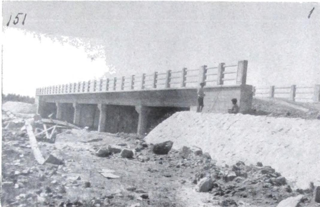
**Vista puente de hormigón armado de 5 tramos, 10 00 m. de luz cada uno.**
