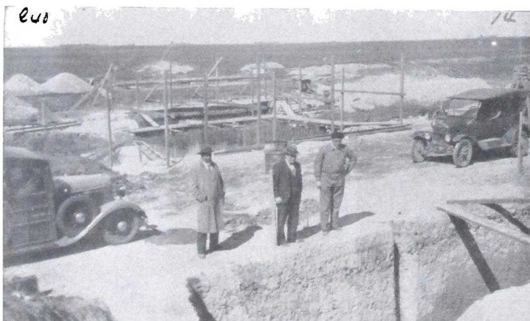
Excavación fundación puente hormigón armado de 3 tramos de 15 m. de luz c/u., sobre canal Nº 11.
