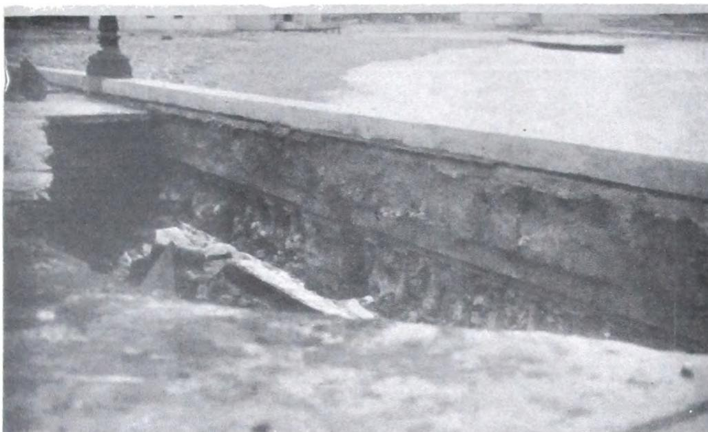
**Muro Punta Gruta — Parte derrumbada y vista de la deficiencia en la construcción
