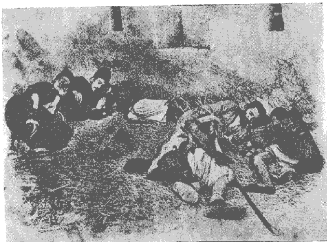
داخل شیره کش خانه
