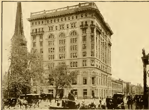
METROPOLITAN LIFE INSURANCE BUILDING, MADISON SQUARE. GEBÄUDE DER METROPOLITAN LEBENSVERSICHERUNGS- GESELLSCHAFT.
