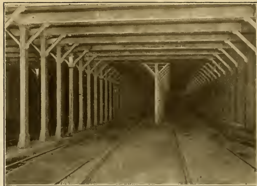
VIEW UNDERGROUND, RAPID TRANSIT TUNNEL ANSICHT VOM UNTERGRUND, EILVERKEHRSTUNNEL
