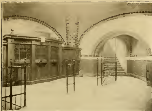
CITY HALL TICKET OFFICE, RAPID TRANSIT TUNNEL RATHAUS FAHRKARTEN VERKAUF, EILVERKEHRSTUNNEL
