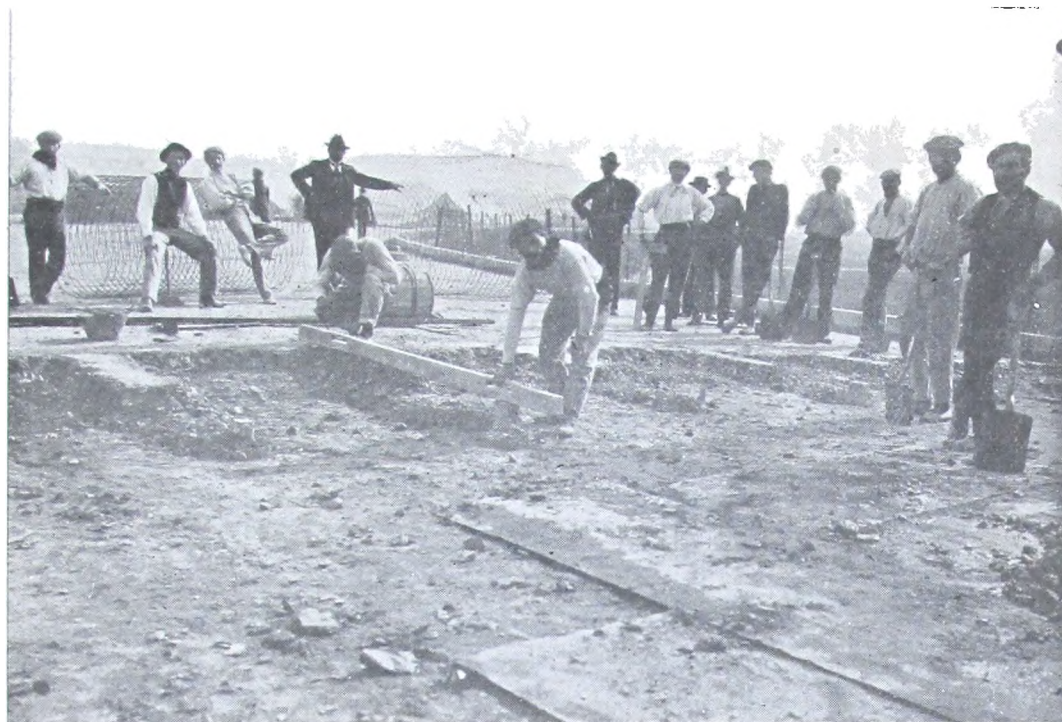
Construcción de la plataforma de hormigón con refuerzo de malla Clinton para el adoquinado del kilómetro 49,250
