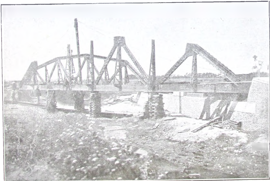
Armamento de la parte metálica del puente oblicuo de 31 m., kil. 1,925 Enero 30 de 1915
