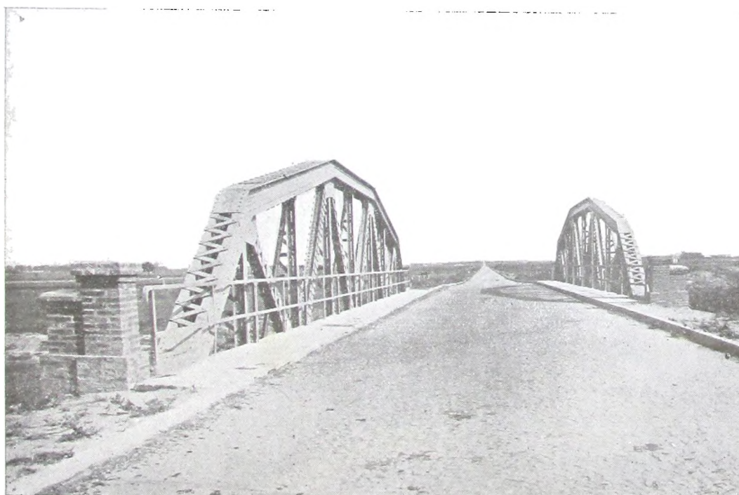
Puente oblicuo de 31 m., kilómetro 1,925 terminado
