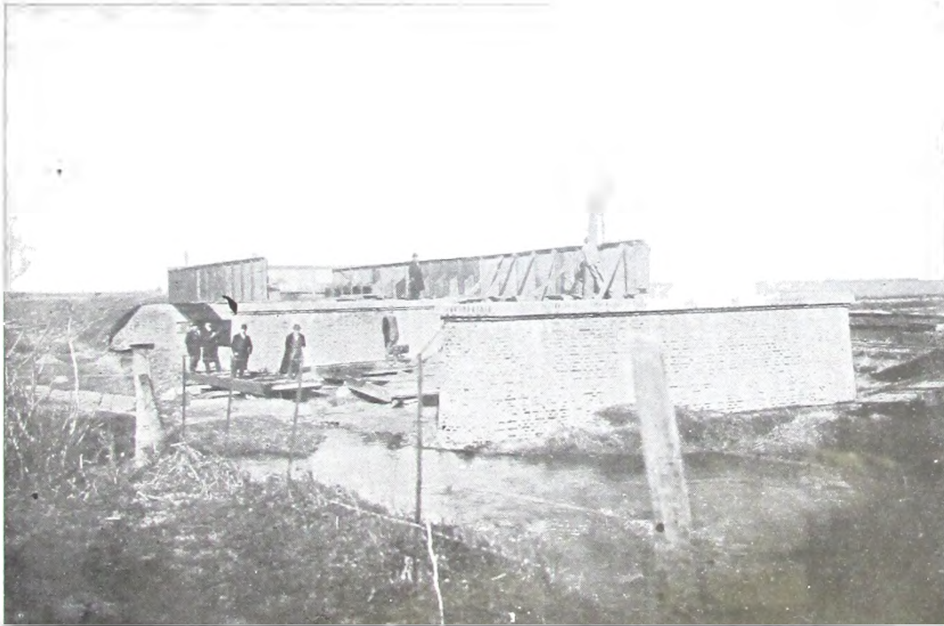
Armamento de la parte metálica del puente de 45 m., kilómetro 24,230. Junio 24 de 1914
