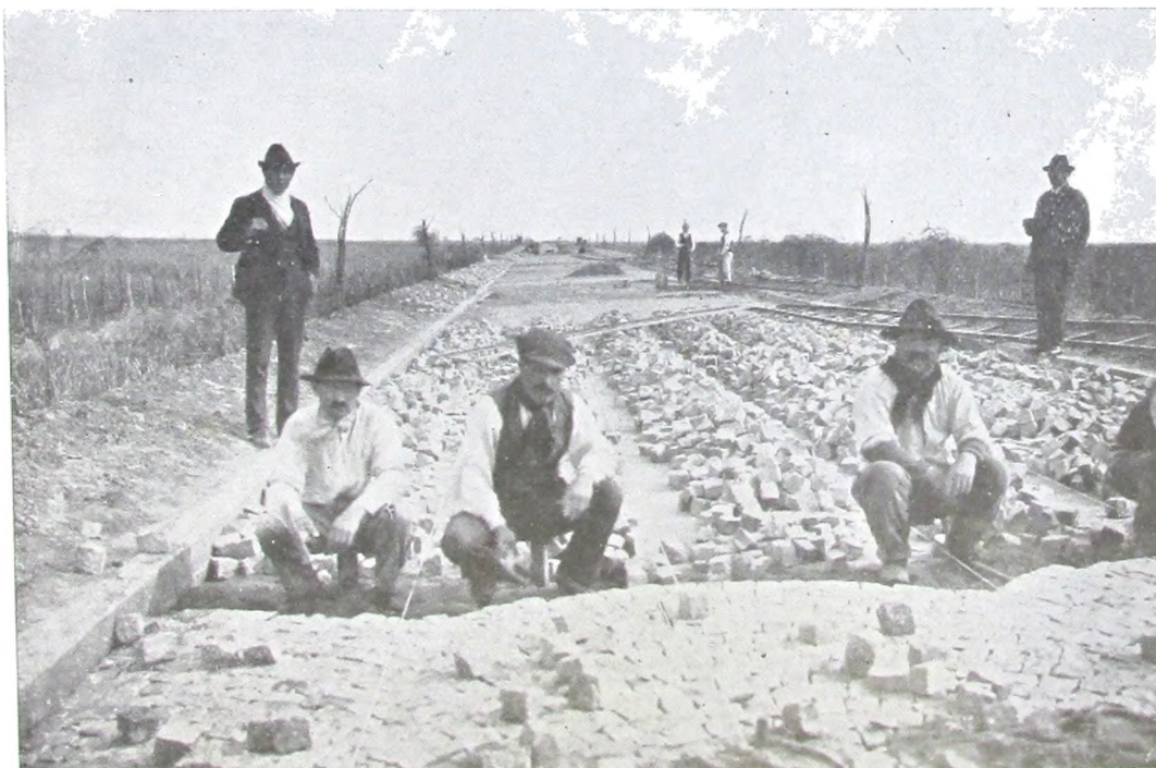
Construcción del adoquinado en el kilómetro 37,400
