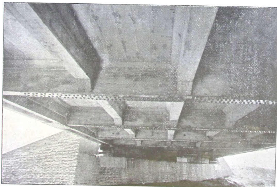
Vista inferior del tablero sin el encofrado del puente oblicuo de 31 m., kilómetro 1,925
