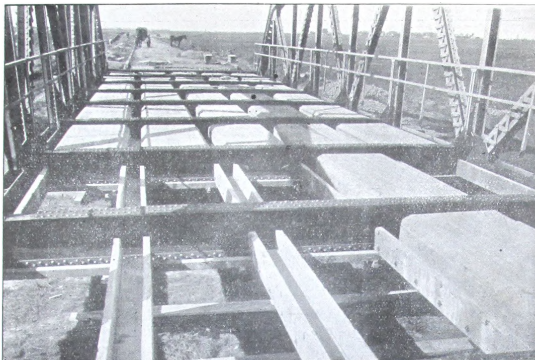
Armamento del encofrado del tablero de hormigón armado del puente de 30 m. Kilómetro 7,780
