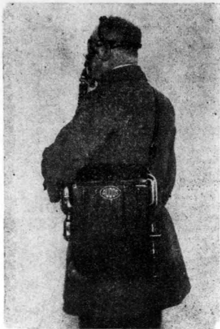
附圖 56. 第一號半“奧多斯”器具 (Audos Nr.1 1 / 2 ) 韓賽亞器具製造公司之1925年模型,備有口塊及防氣體之眼鏡(Gasschutzbrille),而可用一小時半者。
