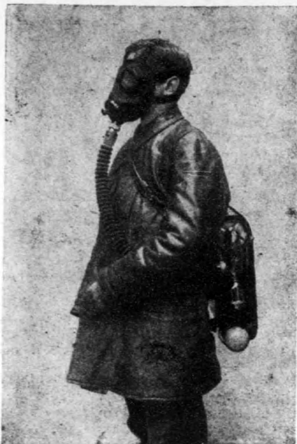
附圖 55. 第一號“奧多斯”器具(Audos Nr. 1) 韓賽亞器具製造公司 (Hanseatische Apparatebau-gesellschaft) 之 1926 年模型,內中備有“阿不脫力”面具 (Optolix-Maske),而可用一小時者。
