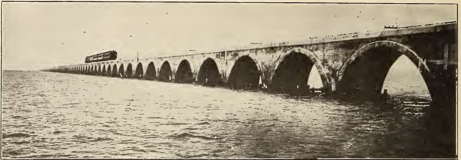
Vista parcial del ferrocarril sobre los cayos de la Florida, que cubre una distancia sobre el mar de ciento siete millas.
