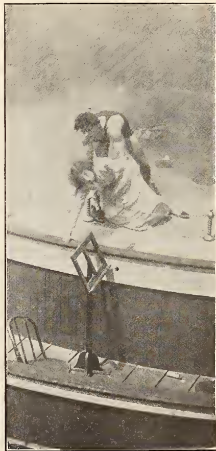
"LA ESTRELLA" (Reliance) Otro efecto de incendio
