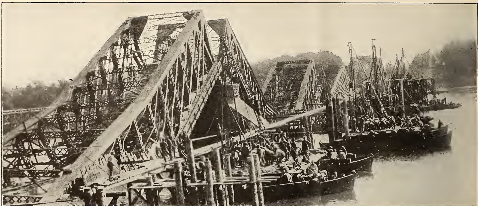
Ingenieros alemanes reparando un puente destruído por las fuerzas rusas en las cercanías de Varsovia. (War Film Syndicate.)
