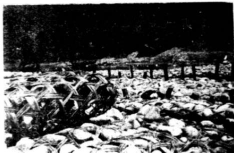
六、人字堤 爲接近飛沙堰龍堤工程，該堤常離壩水勢迴漩之處，洪水時亦係滄水河漕之一。
